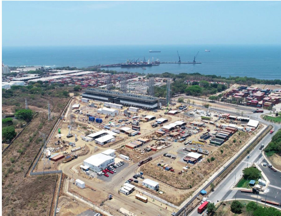
Figura 16: planta de generación de Gas Natural. Foto de archivo de SIGET.
