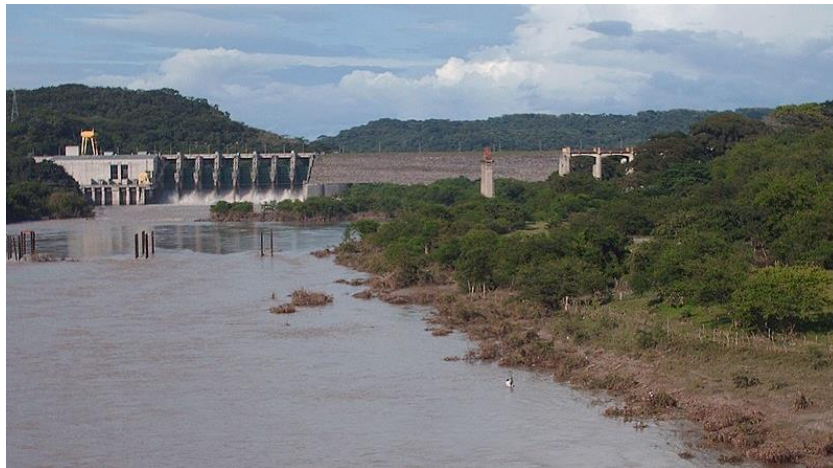
Figura 5: central hidroeléctrica 15 de septiembre. Foto de archivo CEL.
