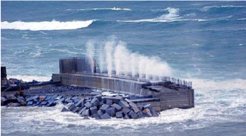
Figura 52: central eléctrica convertidor columna de agua oscilante Mutriku.
