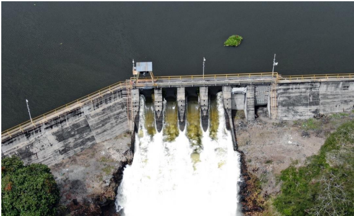
Figura 1: central hidroeléctrica Guajoyo.
