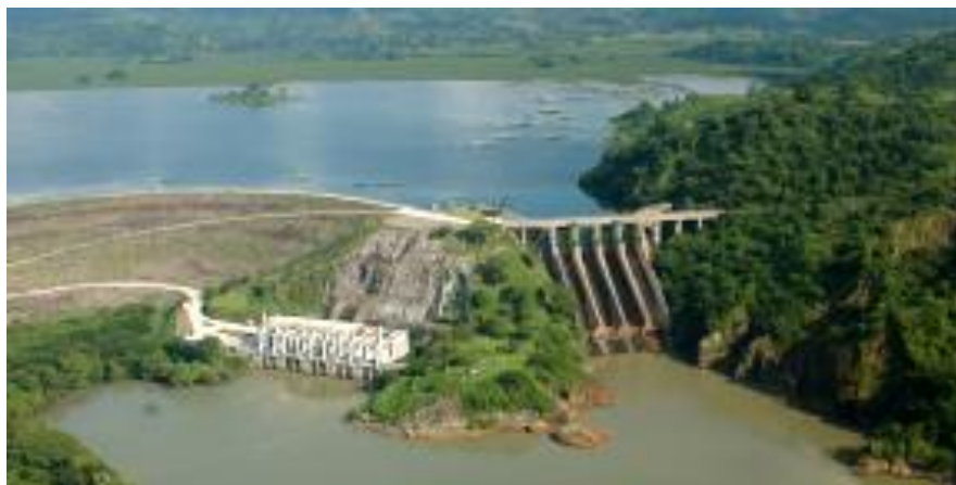
Figura 4: central hidroeléctrica Cerrón Grande. Foto de archivo CEL.
