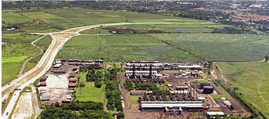
Figura 7: central Térmica Nejapa Power. Foto cortesía de AES El Salvador.
