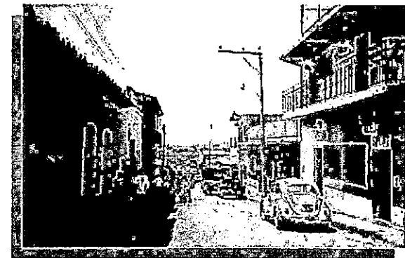
* Vista hacia el poniente de la calle Morazán, en la cual se observa el mercado ubicado a lo largo de ésta.
