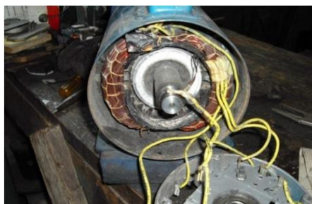
Figura 3.6. Fotografías de algunos daños más comunes como son las bobinas quemadas. 29
