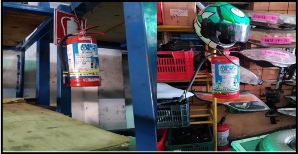
**Imagen 3.** Ubicación de extintores en lugares donde obstruye el paso para poder tomarlo en caso de alguna emergencia y además, otros que no están en su lugar correspondiente y debidamente recargados.
