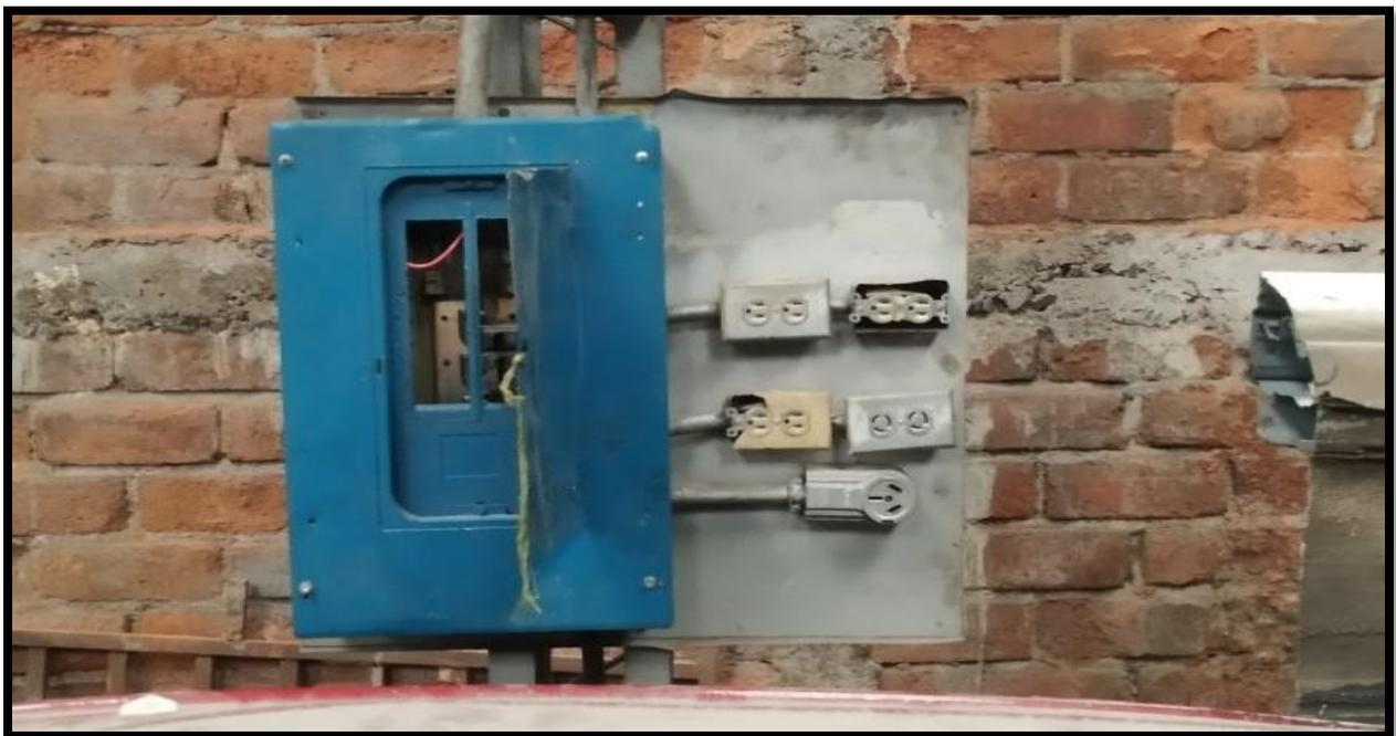
**Imagen 8.** Instalación eléctrica dañada en bodega, no cuenta con rotulo de señalización.
