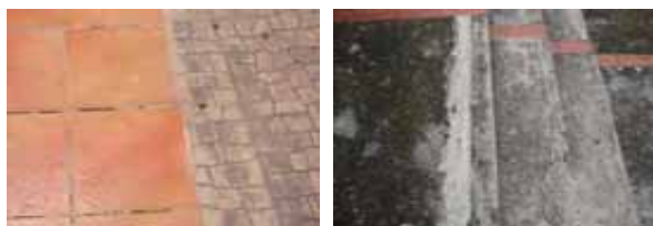
FIG.255 Izquierda: Fotografía de los tipos de piso de concreto estampado del atrio. Derecha: Fotografía del piso encementado de los patios laterales.
