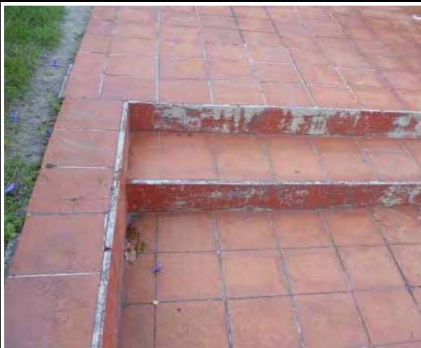
FIG.434 Fotografía del piso exterior de la iglesia.
