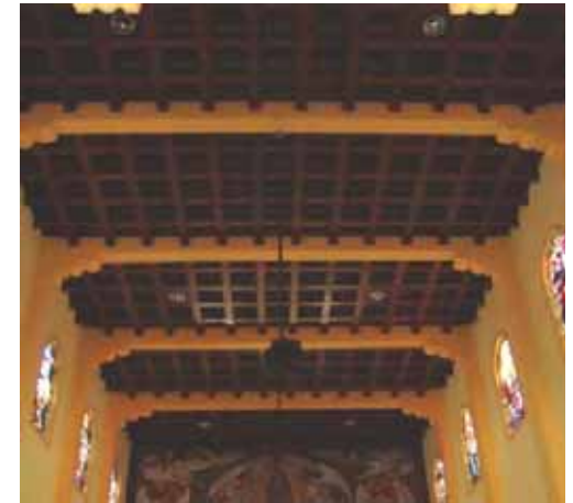
FIG.617 Fotografía del cielo falso de la nave central
