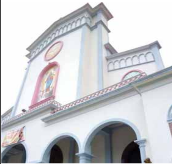
FIG.658 Fotografía de las paredes exteriores de la iglesia.
