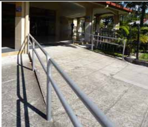
FIG.499 Fotografía del piso del atrio de la iglesia.
