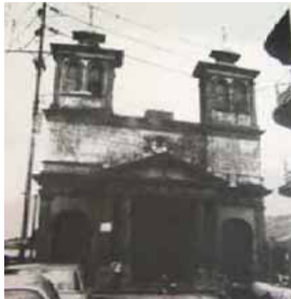
FIG.378 Fotografía de la Iglesia San Esteban donde se observan los chapiteles en las torres.
