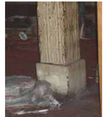
FIG.386 Fotografía de la base de las columnas interiores, tomada en 2012
