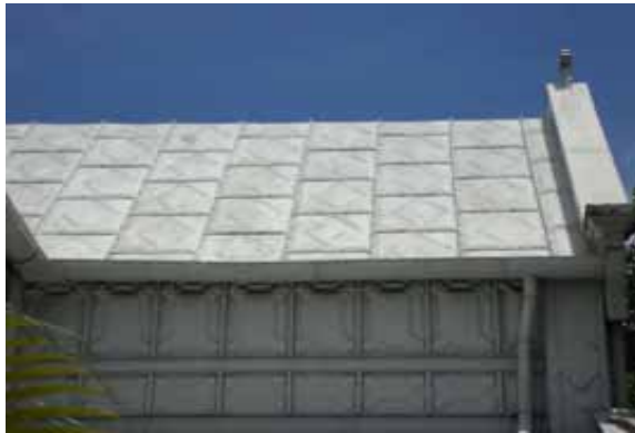
FIG.561 Fotografía del material que cubre los techos de la capilla
