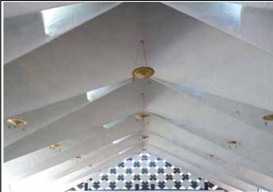
FIG.689 Fotografía del interior de la capilla donde se observa la estructura del techo, siguiendo la forma de los marcos triangulares.
