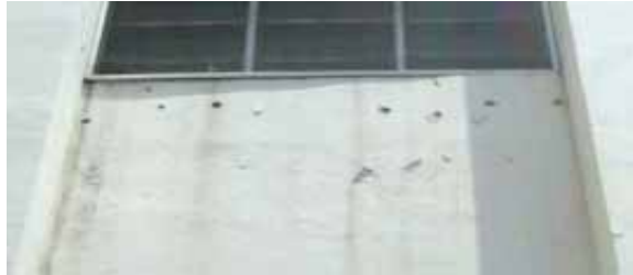
FIG.85 Fotografía del acabado en las paredes exteriores
