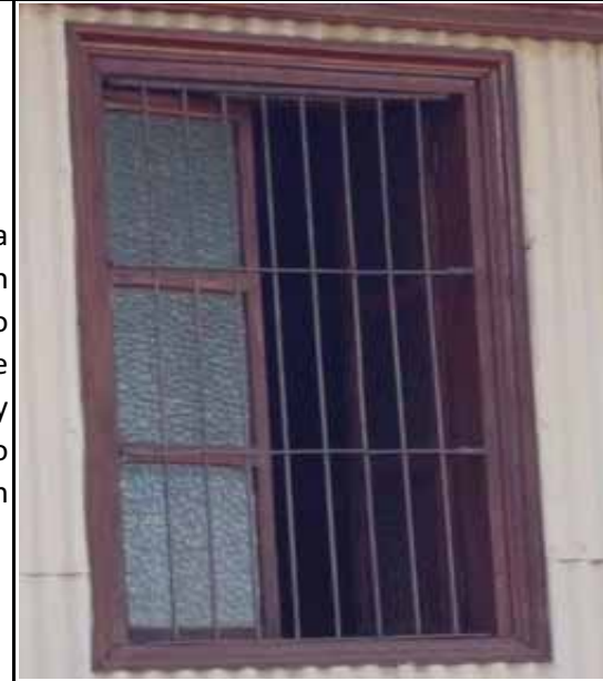
FIG.421 Fotografía interior de una de las ventanas del templo.
