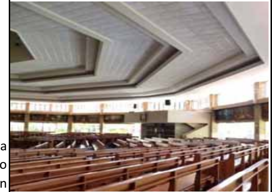
FIG.495 Fotografía del cielo falso del cuerpo central de la iglesia.
