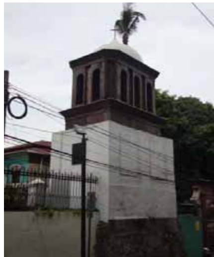
FIG.250 Fotografía del campanario, en la que se aprecia la cúpula que lo cubre
