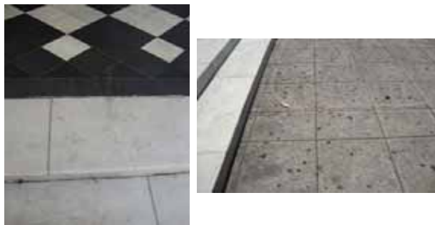
FIG.621 Fotografías del tipo de piso exterior. Nótese el cambio entre la baldosa de cemento del portal, el mármol blanco de las gradas y el encementado del atrio.
