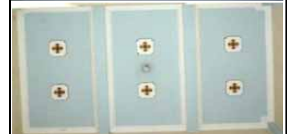
FIG.657 Fotografía del cielo falso del vestíbulo y los altares laterales respectivamente.
