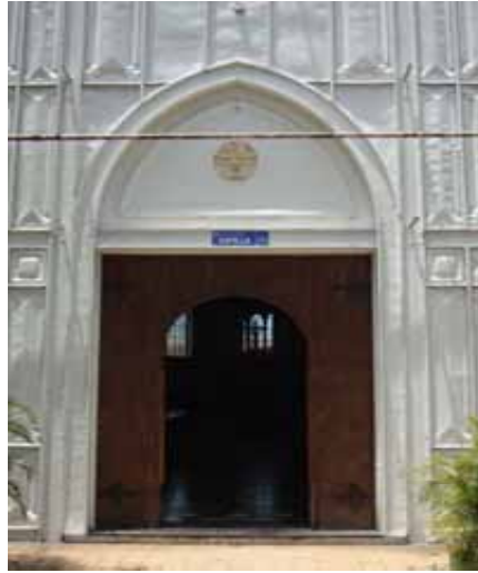
FIG.549 Fotografía del acceso principal de la capilla
