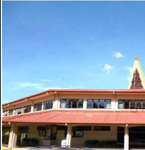
FIG.494 Fotografía de la cubierta del techo de la iglesia, que es de lámina tipo teja.
