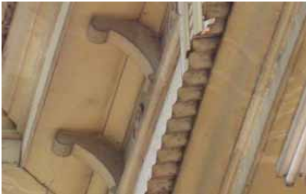
FIG.175 Fotografía que muestran los canecillos tallados en madera.
