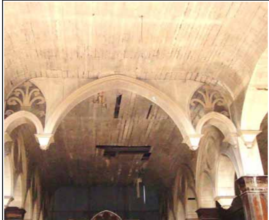
FIG.536 Fotografía del cielo falso machihembrado de madera de la iglesia.
