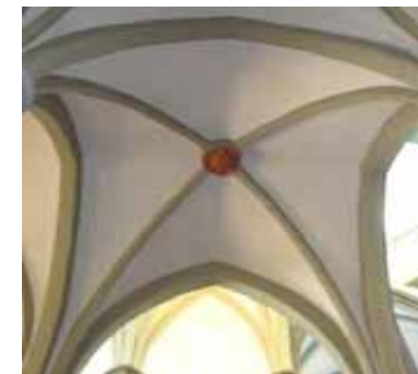
FIG.300 Fotografía de una de las bóvedas de crucería de concreto armado.
