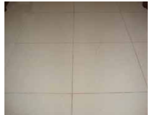
FIG.750 Fotografía del tipo de piso interior, tomada en 2012.
