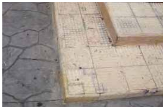
FIG.212 Fotografía de los tipos de piso exteriores, tomada en 2012.
