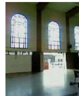
FIG.253 Fotografía de un tramo de pared interior de la nave lateral norte.
