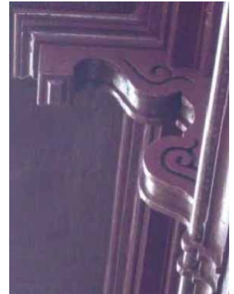
FIG.423 Fotografía exterior de la iglesia parroquial Nuestra Señora de Candelaria, mostrando el detalle de la cornisa de madera que rodea toda la elevación lateral.
