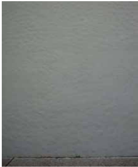
FIG.814 Fotografía del acabado en paredes exteriores
