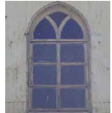
FIG.529 Fotografía de una de las ventanas de la parte superior de la nave central.
