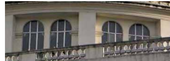
FIG.75 Fotografía del tipo de ventanas en el tambor de la cúpula
