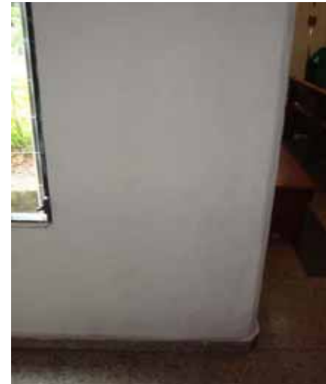
FIG.815 Fotografía del acabado en las paredes interiores
