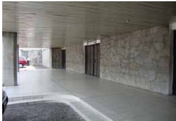
FIG.718 Fotografía del vestíbulo, en la que se observa el cielo falso de PVC.
