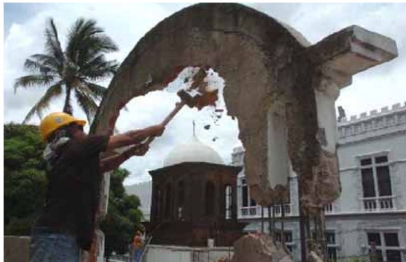
FIG.218 Fotografía de la remodelación de la fachada principal en 2011.
