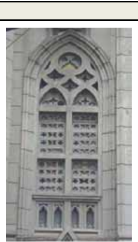
FIG.283 Fotografía de la ventana ubicada sobre uno de los accesos laterales
