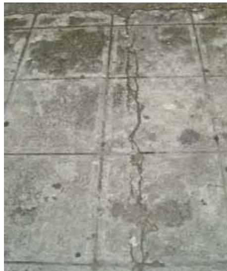
FIG.87 Fotografía del tipo de piso exterior
