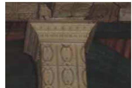
FIG.387 Fotografía del capitel de las columnas interiores, tomada en 2012
