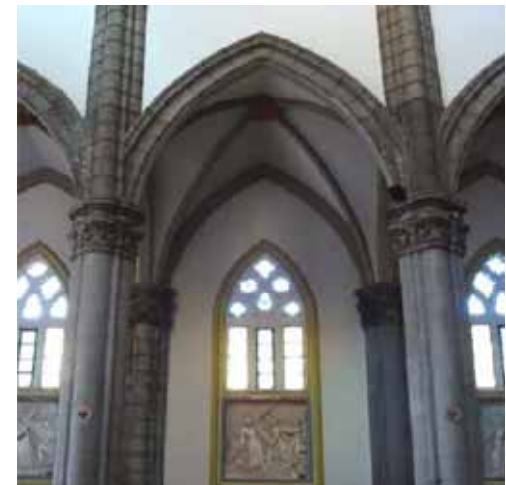
FIG.299 Fotografía de uno de los arcos ojivales, sobre los capiteles de los pilares cruciformes.
