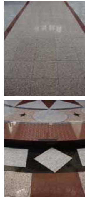
FIG.88 Fotografías de los tipos de piso colocados al interior de la Catedral
