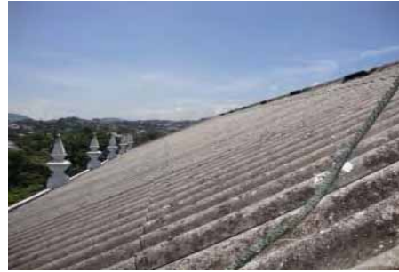
FIG.614 Fotografía del material de cubierta de la nave central.
