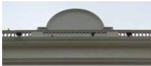
FIG.66 Fotografía del antepecho y balaustrada.
