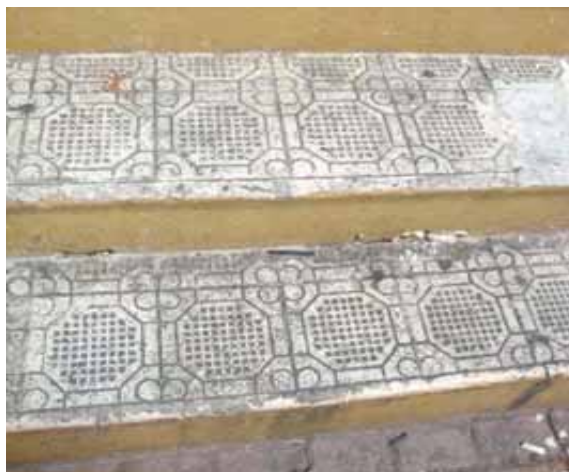
FIG.539 Fotografía del piso del atrio de la iglesia.
