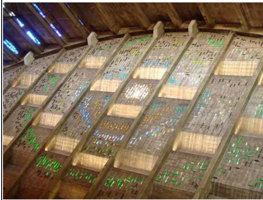
FIG.135 Fotografía interior de una del detalle de los módulos de concreto, que sirven de ventilación e iluminación para la iglesia.
