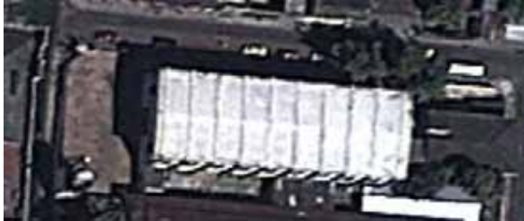
FIG.249 Vista aérea de la iglesia parroquial La Merced, donde se observa la losa de concreto del techo.
