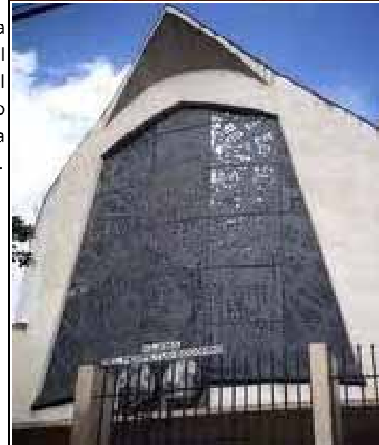
FIG.766 Fotografía superior vista interna del vitral. Fotografía inferior vista exterior del vitral de la fachada.
