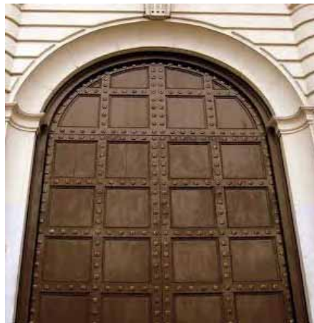
FIG.62 Arriba: Fotografía del acceso principal. Abajo: Detalle de la puerta del acceso principal 23 .
