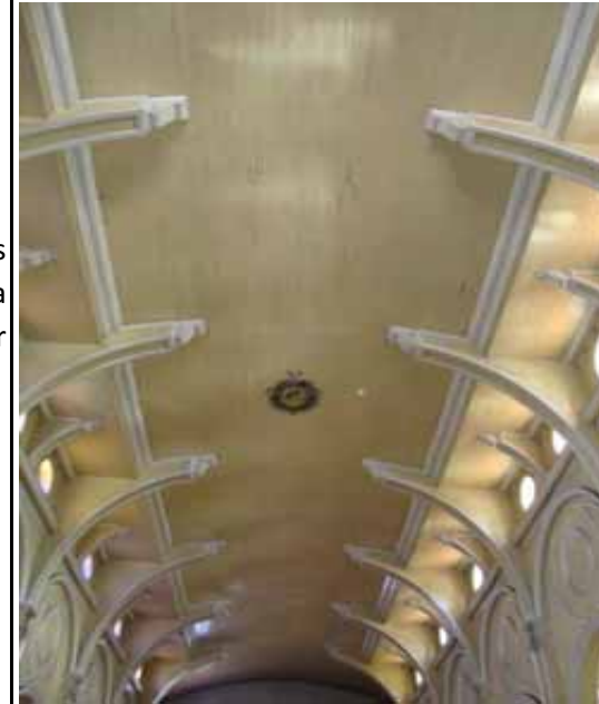
FIG.181 Fotografía de la nave lateral central mostrando el cielo falso de madera.
