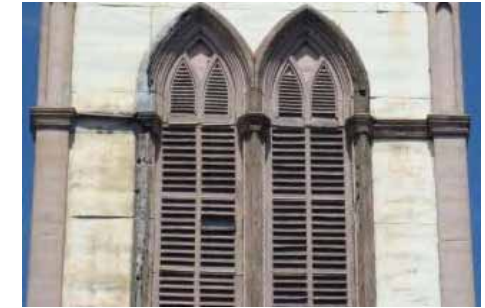
FIG.528 Fotografía de la ventana ubicada al pie de las torres.
