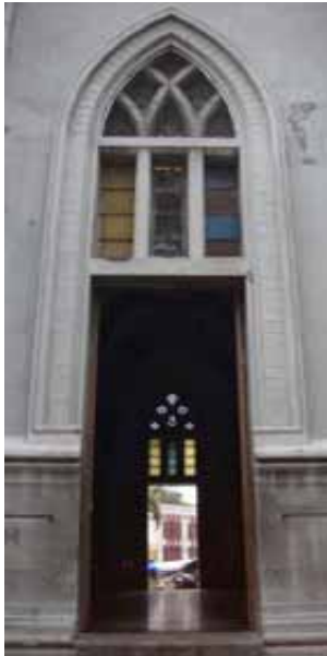
FIG.291 Fotografía exterior de la puerta del acceso lateral sur.
