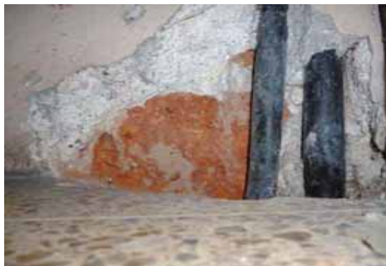
FIG.776 Fotografía interior de la iglesia Parroquial, mostrando en un pequeño detalle la utilización de cada uno de los materiales que son parte del sistema constructivo.
