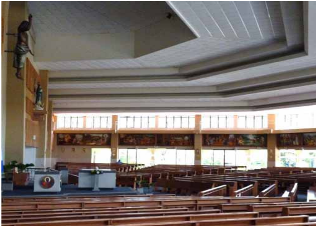
FIG.492 Fotografía interior de la iglesia parroquial Inmaculada Concepción de Santa Tecla, donde se observan los elementos estructurales que la conforman.
