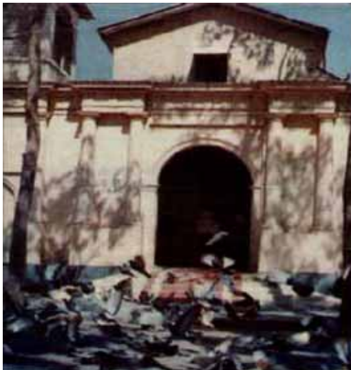
FIG.199 Fotografía de una parte de la fachada principal de la iglesia parroquial San José. Se observa parte de la torre ubicada al costado oeste.
