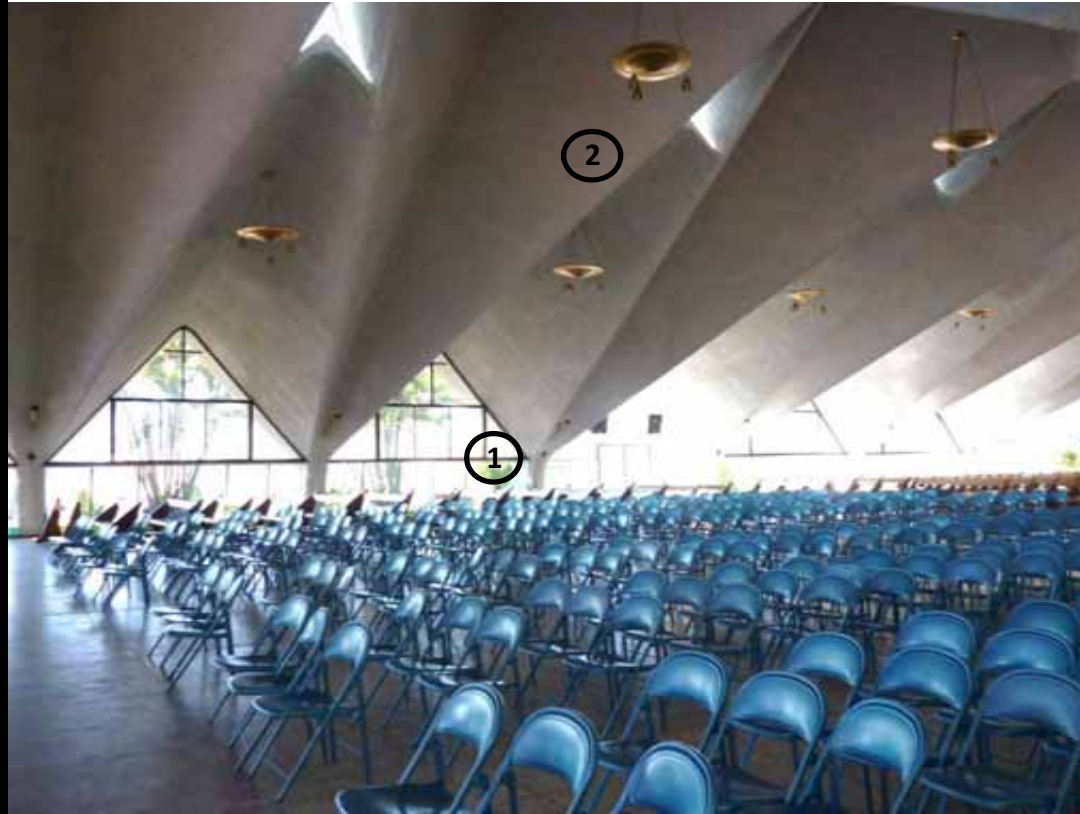
FIG.685 Fotografía interior de la capilla del Colegio Externado San José, donde se observan los elementos estructurales que la conforman.
