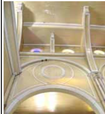
FIG.179. Fotografía donde se observan las molduras de medio punto y las ménsulas.
