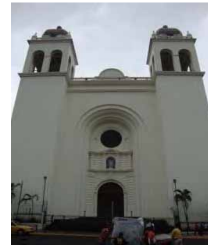
FIG.70 Fotografía del estado actual de la fachada principal.
