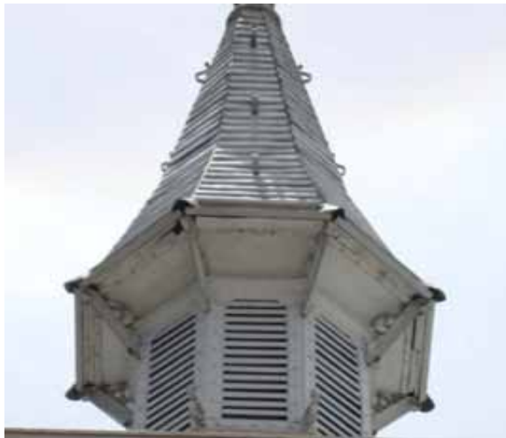
FIG.562 Fotografía del chapitel piramidal, cuya cubierta es de lámina acanalada.
