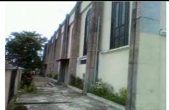
FIG.247 Fotografía exterior de las columnas de concreto armado.
