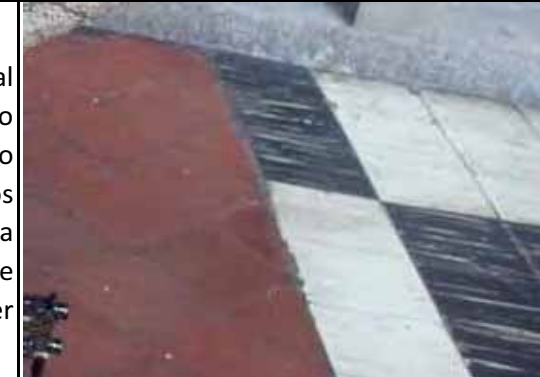
FIG.149 Fotografía del piso interior.
