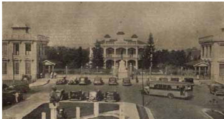
FIG.542 Fotografía de la fachada principal del Hospital Rosales, tomada durante la primera mitad del siglo XX.
