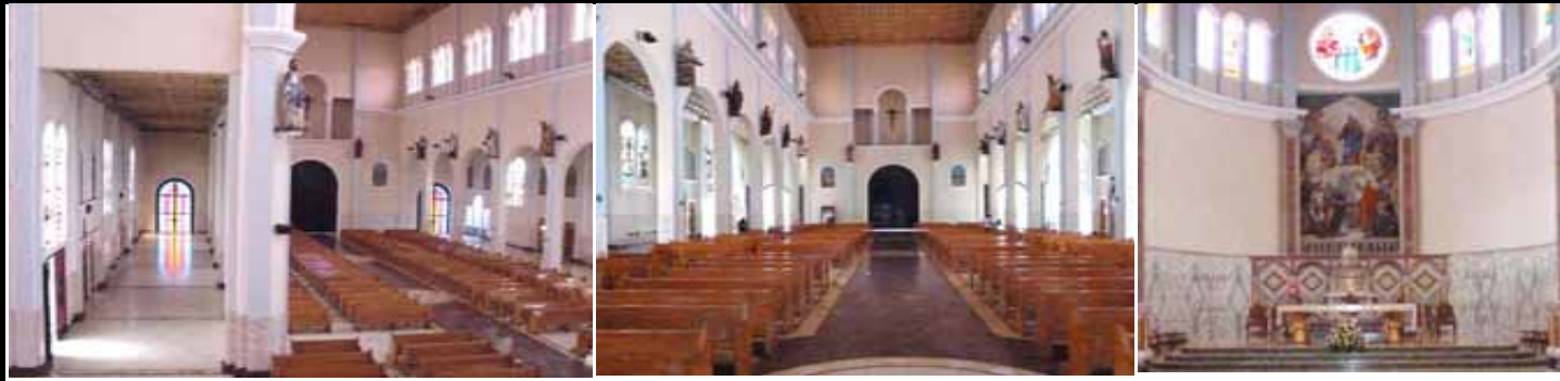
FIG.629 Fotografías interiores de la iglesia parroquial, donde se observa la diferencia entre el ancho y alto de la nave central respecto a las naves laterales y el Altar mayor al fondo de la nave central.
