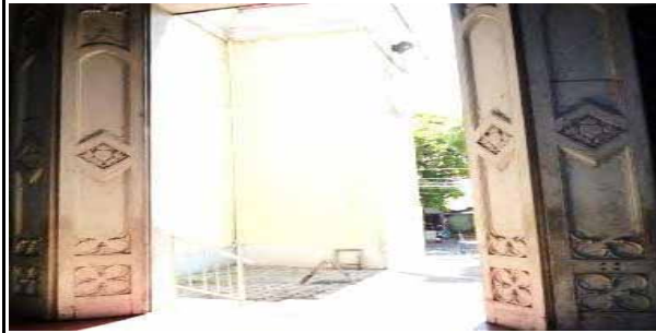
FIG.332 Fotografía de las puertas laterales de cuatro hojas, elaboradas en madera.
