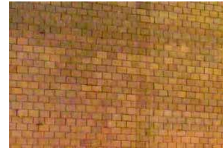
FIG.147 Fotografía exterior de la pared norte.
