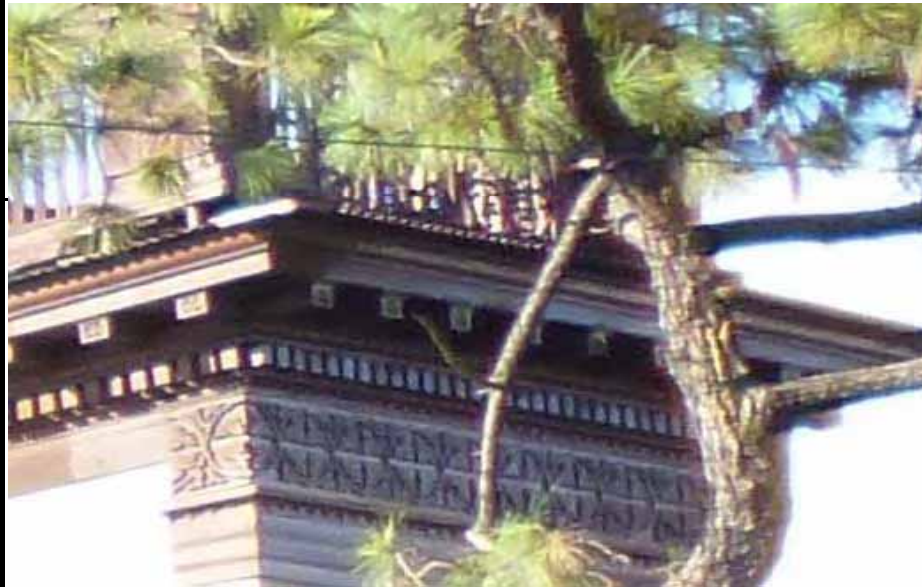
FIG.422 Fotografía exterior de la iglesia parroquial Nuestra Señora de Candelaria, donde se observa parte de la elevación lateral este, mostrando una cornisa sostenida por canecillos sencillos tallados en madera, un friso compuesto por denticulos y una laceria tallada en madera con motivos florales.
