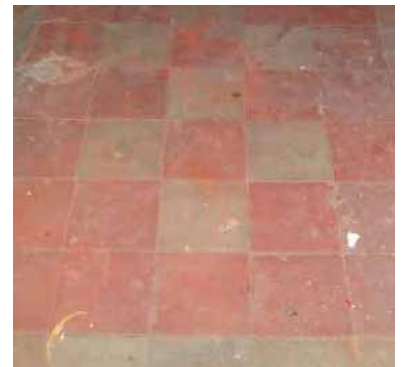
FIG.397 Fotografía del piso interior del primer nivel, tomada en 2012.
