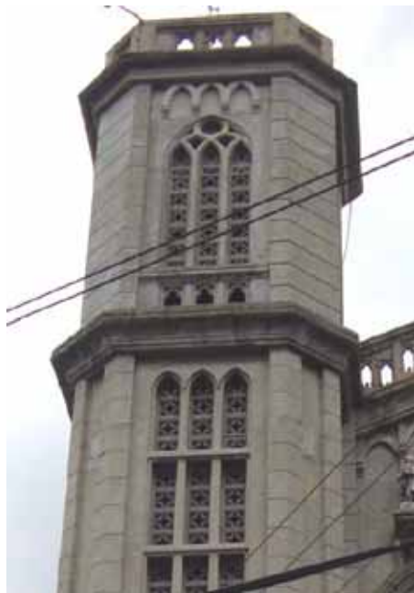
FIG.286 Fotografía de la torre sur, donde se observan las cornisas de cincha.
