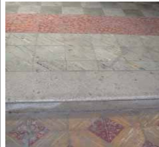
FIG.540 Fotografía del piso interior de la iglesia.
