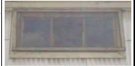
FIG.173 Fotografía de las ventanas a lo largo de la nave central.
