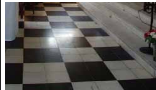
FIG.622 Fotografía de los tipos de piso interiores. Nótese el cambio entre el piso de las naves y el piso de los altares.
