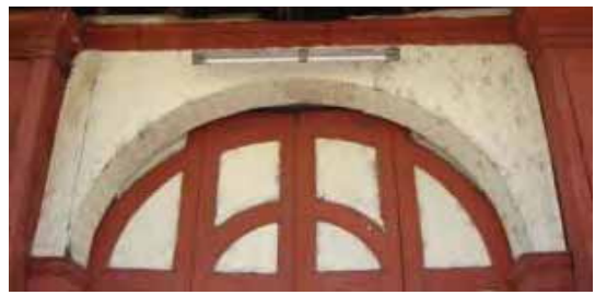
FIG.394 Fotografía del arco de medio punto de la puerta principal, el cual conservaba el revestimiento de lámina troquelada
