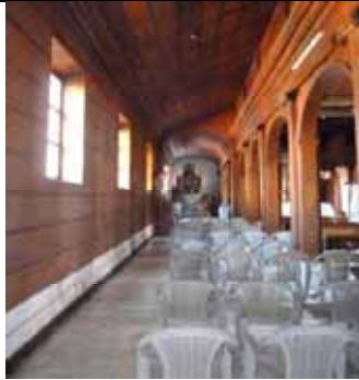
FIG.402 Fotografía de la nave lateral sureste del templo.
