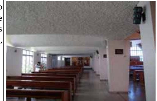
FIG.720 Fotografía de la nave lateral norte, donde se aprecian las losas convexas de concreto que la cubren.
