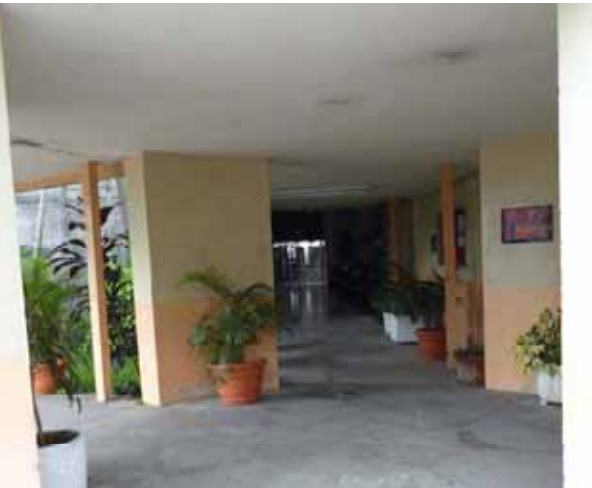
FIG.780 Fotografía del pasillo de conexión entre la iglesia y el campanario.
