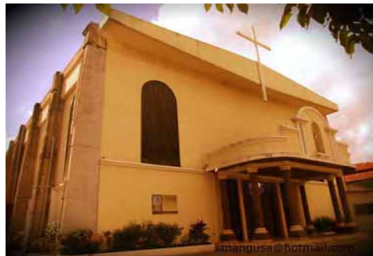
FIG.216 Fotografía de la iglesia parroquial La Merced, construida en 1970.
