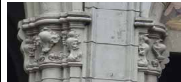
FIG.288 Fotografía de los capiteles ubicados en el acceso principal
