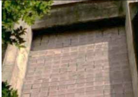
FIG.144 Fotografía exterior de la pared sur.
