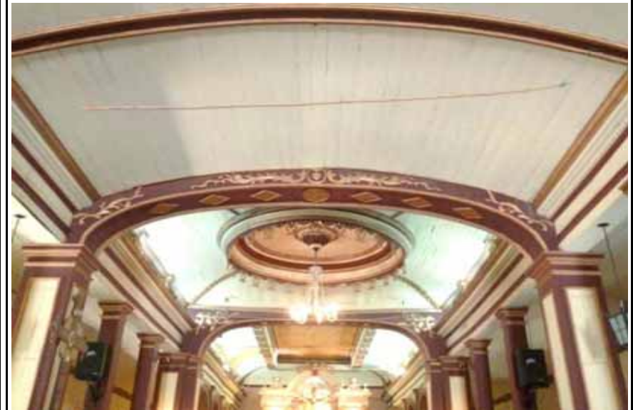
FIG.467 Fotografía del cielo falso machihembrado, del resto de la nave central.
