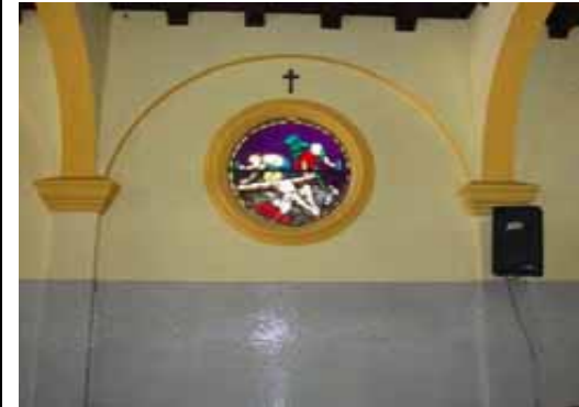
FIG.620 Fotografía de un tramo de pared interior de la nave lateral norte.
