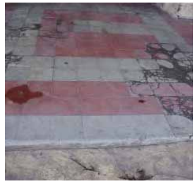
FIG.395 Fotografía del tipo de piso exterior. Nótese el cambio entre el ladrillo de cemento del pórtico y el concreto estampado de la acera.
