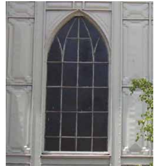
FIG.552 Fotografía de la ventana del extremo norte del transepto.
