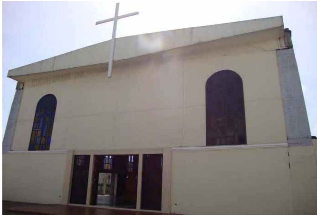
FIG.241 Fotografía de la fachada principal de la parroquia La Merced, tomada en 2012.
