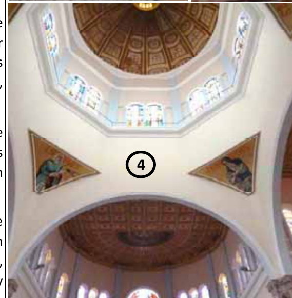
FIG.653 Fotografía del cimborrio que sobre sale en el crucero de la iglesia con sus elementos estructurales.
