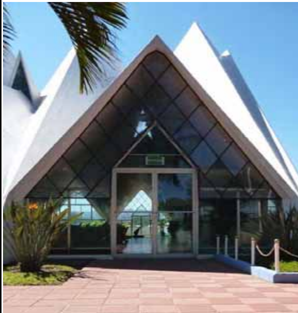
FIG.680 Fotografía del acceso lateral que conduce hacia el interior de la capilla.
