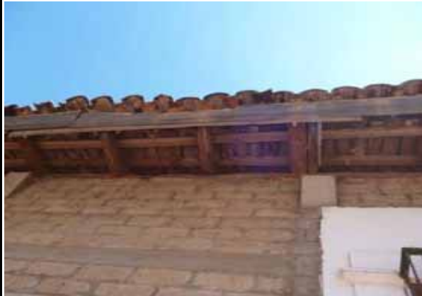
FIG.464 Fotografía donde se puede ver parte de la estructura del techo que cubre a toda la iglesia.
