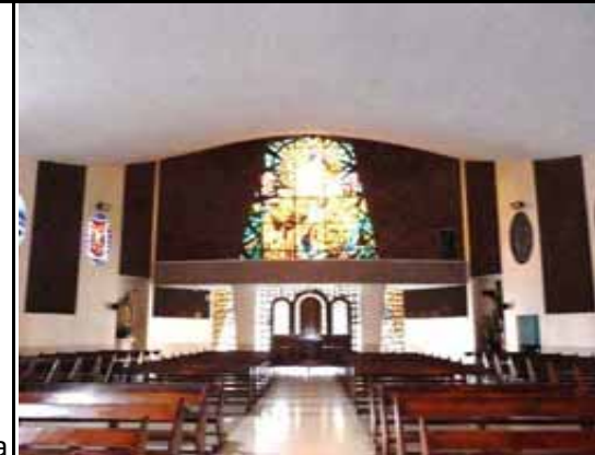
FIG.781 Fotografía del cielo de la nave central.
