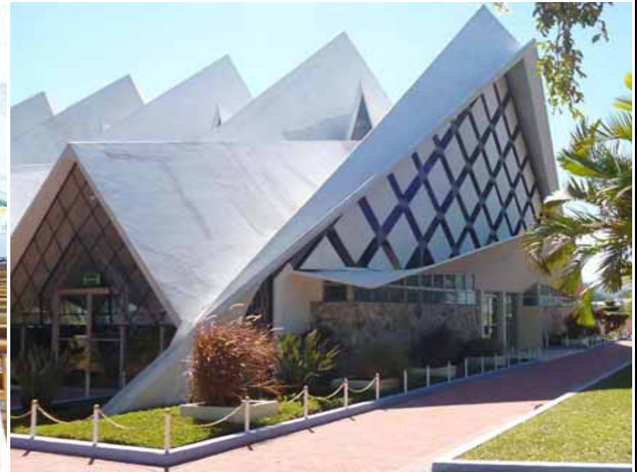
FIG.678 Fotografía de la elevación principal de la capilla del Colegio Externado San José. Nótese la sobriedad decorativa en la fachada.
