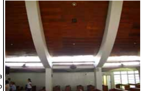
FIG.719 Fotografía del cielo falso de la nave central.
