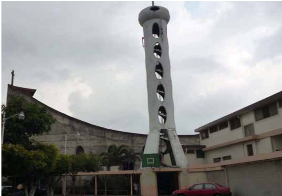
FIG.773 Fotografía exterior de la iglesia parroquial El Perpetuo Socorro, donde se observa parte de la elevación lateral norte, libre de elementos decorativos.
