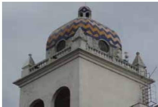
FIG.68 Fotografía del remate de la torre este, tomada en 2012.
