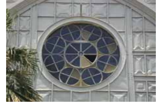
FIG.551 Fotografía del óculo de la fachada principal
