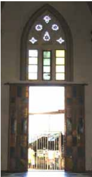
FIG.292 Fotografía interior de la puerta del acceso lateral sur
