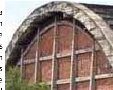
FIG.140 Fotografía de los marcos estructurales.
