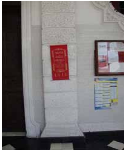
FIG.619 Fotografía de un tramo de la pared de la fachada principal, donde se aprecia el cambio de acabado.
