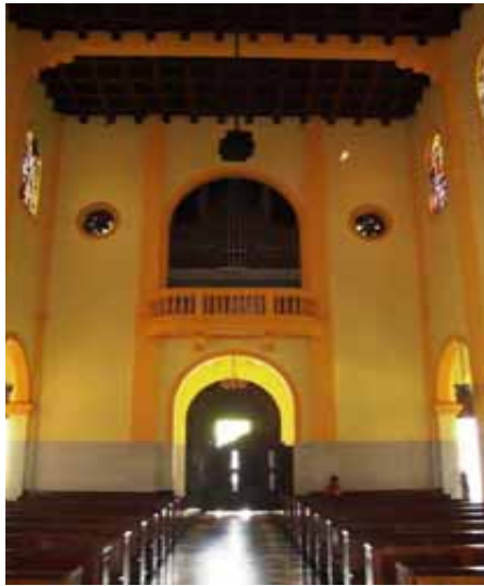
FIG.578 Fotografía del área de coro, ubicado sobre el vestíbulo de ingreso.
