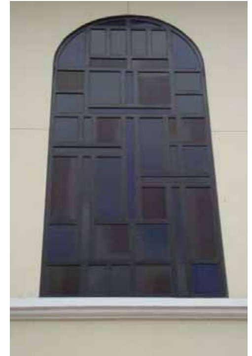
FIG.239 Fotografía del tipo de ventana existente en la fachada principal.
