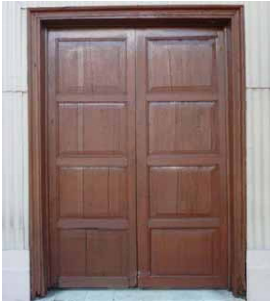
FIG.420 Fotografía de la puerta lateral del templo.
