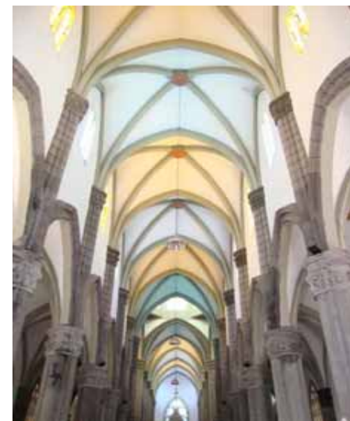
FIG.302 Fotografía de las bóvedas de crucería, que a la vez sirven de cielo falso para las naves de la iglesia parroquial.
