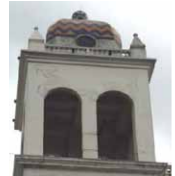
FIG.64 Fotografía de los vanos de la torre este del campanario.
