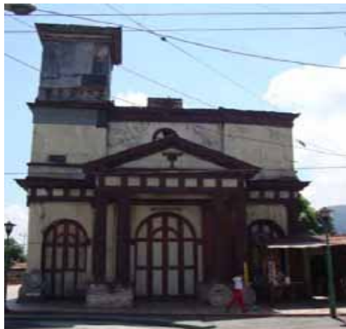
FIG.368 Fotografía de la fachada principal de la iglesia parroquial, tomada en 2012.
