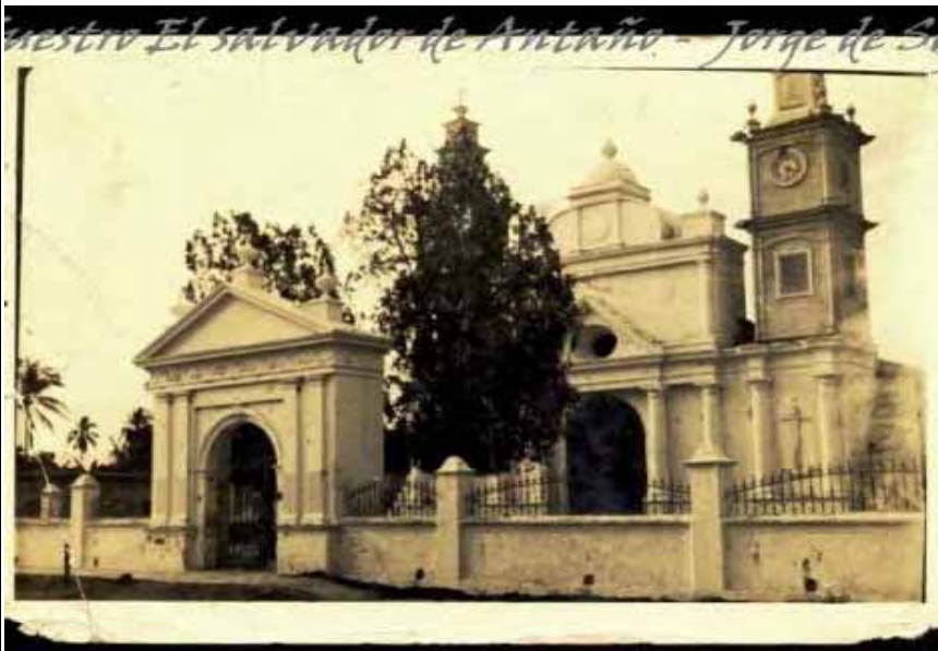
FIG.437 Fotografía de la iglesia parroquial de San Nicolás Obispo de Tonacatepeque, donde puede verse la torre del reloj hecha en madera y lamina de zinc.
