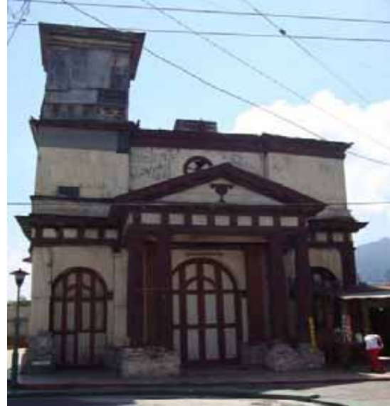
FIG.359 Fotografía de la fachada principal de la iglesia parroquial San Esteban, tomada en 2012.
