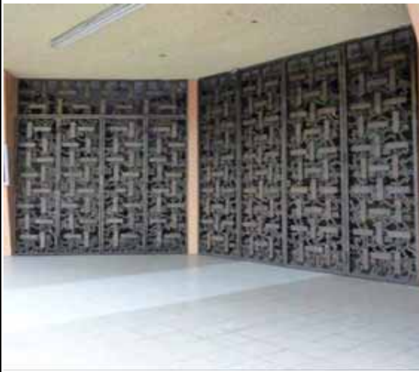
FIG.764 Fotografía de las puertas de acceso a la iglesia.
