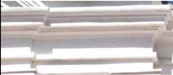
FIG.450 Fotografía del entablamento que rodea la fachada.
