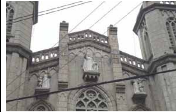
FIG.287 Fotografía del muro de piñon con vanos de concreto.
