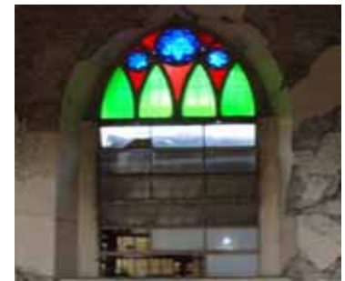
FIG.530 Fotografía interior de una de las ventanas de la nave central.
