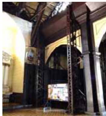
FIG.315 Fotografías de la estructura de refuerzo para las bases de las torres.
