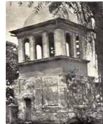
FIG.232 Fotografía del campanario, tomada en 1927.
