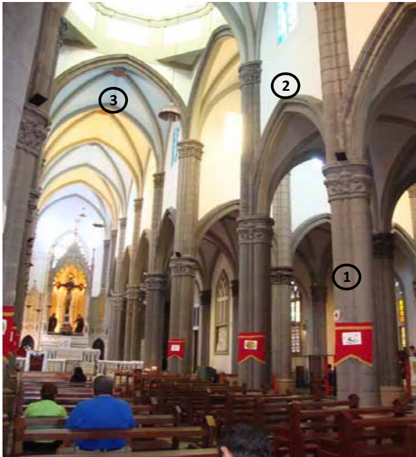
FIG.298 Fotografía interior de la iglesia parroquial El Calvario, donde se observan los elementos estructurales que la conforman.
