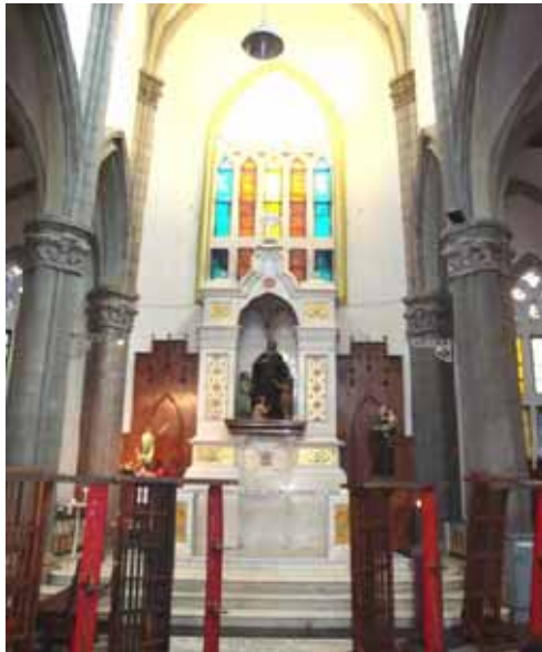
FIG.266 Fotografía del altar norte del transepto
