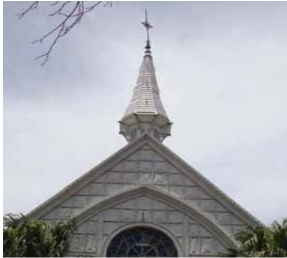
FIG.553 Fotografía de la parte superior de la elevación principal de la capilla, donde se observan las molduras metálicas.
