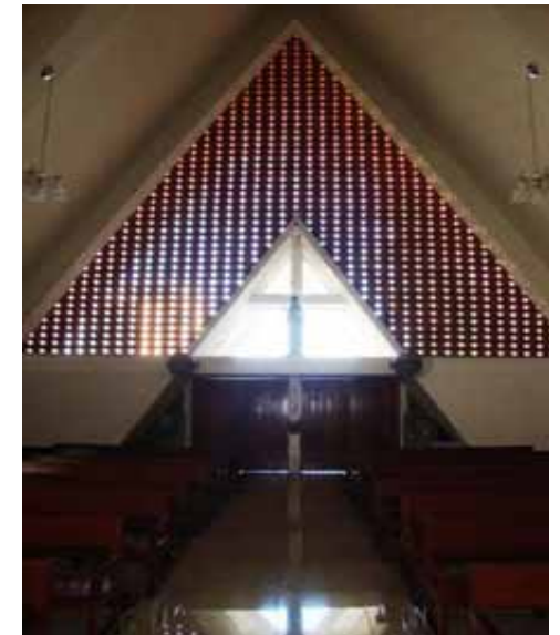
FIG.736 Fotografía interior del acceso principal
