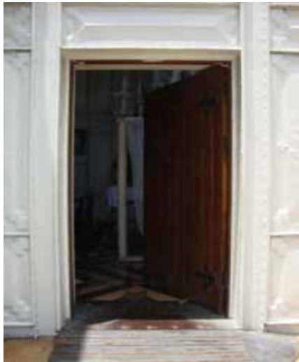
FIG.550 Fotografía del acceso ubicado en el extremo norte del transepto.
