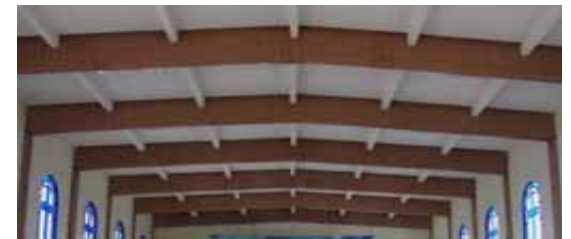
FIG.248 Fotografía de las vigas primarias y secundarias que sostiene la losa del techo.
