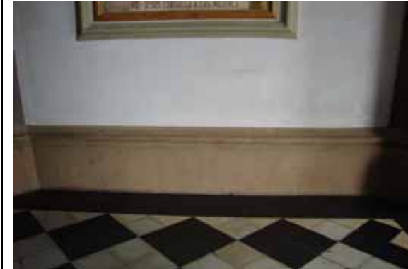
FIG.304 Fotografía de un tramo de pared interior de la nave lateral norte.
