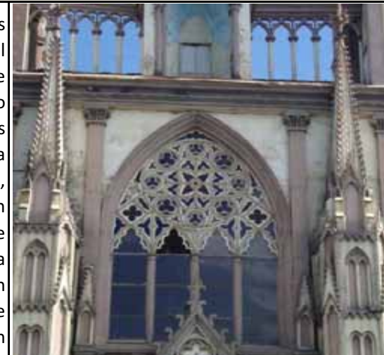
FIG.522 Fotografía del rosetón del Carmen, entre pináculos.
