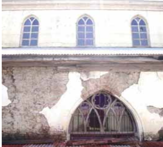
FIG.537 Fotografía de las paredes exteriores de la iglesia.
