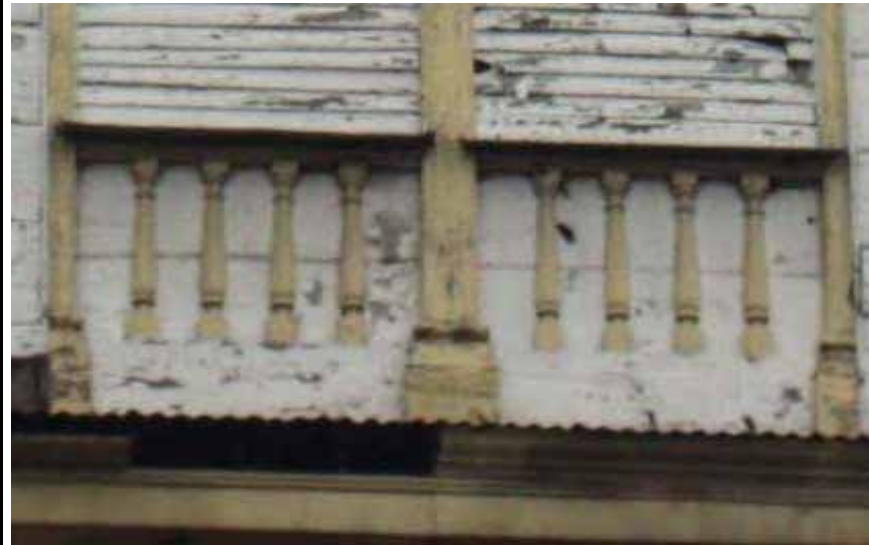
FIG.176 Fotografía del detalle inferior de las torres donde se pueden observar las barandillas.
