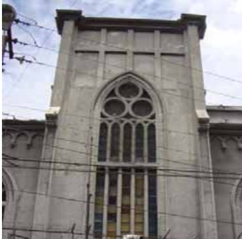
FIG.303 Fotografía de una parte del costado sur del transepto. Nótese el acabado en el exterior de las paredes.
