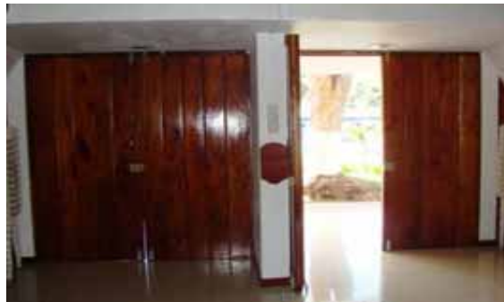
FIG.739 Fotografía de las puertas de acceso
