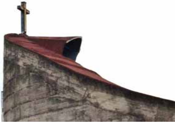
FIG.779 Fotografía donde se puede ver la lámina que cubre la losa de concreto de la iglesia.
