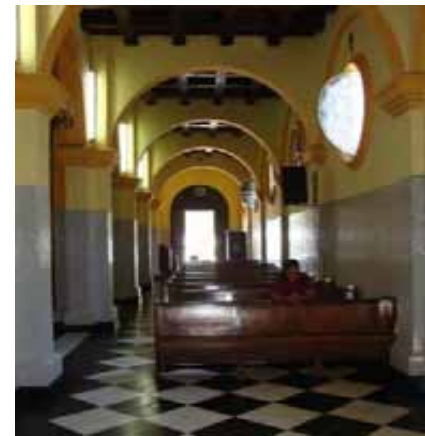
FIG.613 Fotografía de la nave lateral norte. Nótese los arcos de medio punto transversales.
