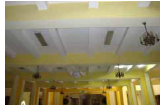
FIG.618 Fotografía de la losa y vigas de concreto de la nave central de la cripta.
