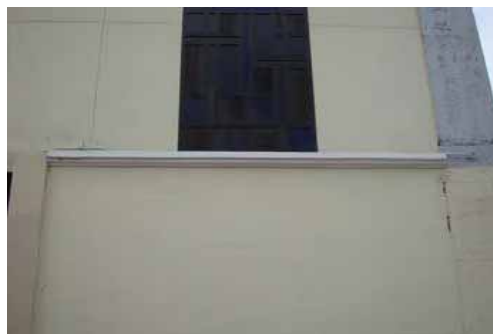
FIG.252 Fotografía del acabado exterior en paredes.
