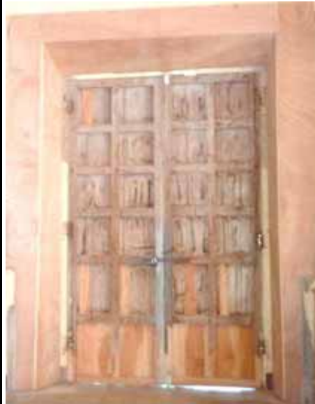
FIG.456 Fotografía interior de la puerta lateral de la iglesia.
