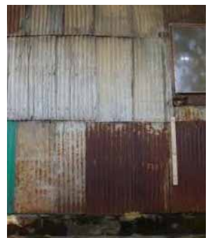
FIG.393 Fotografía del costado sur de la iglesia parroquial, tomada en 2012.
