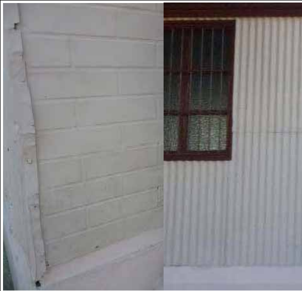
FIG.432 Fotografía de las paredes exteriores de la iglesia.
