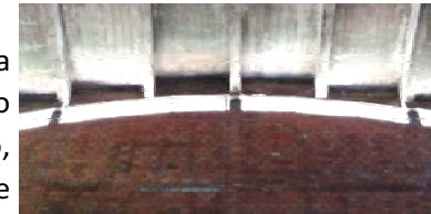
FIG.139 Fotografía de la entrada de luz indirecta por debajo de la viga curva.
