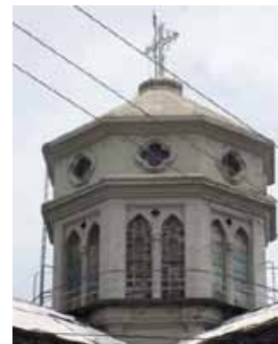
FIG.295 Fotografía exterior de la cúpula octogonal
