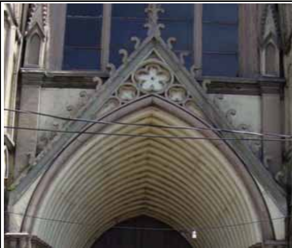
FIG.520 Fotografía del gablete del acceso principal a la iglesia.
