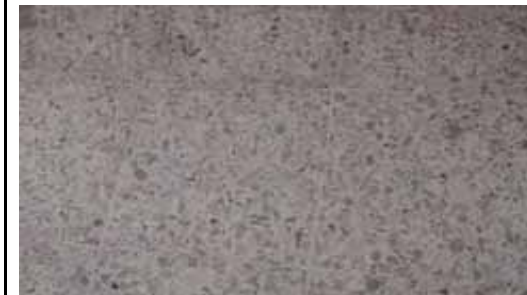
FIG.724 Fotografía del tipo de piso interior
