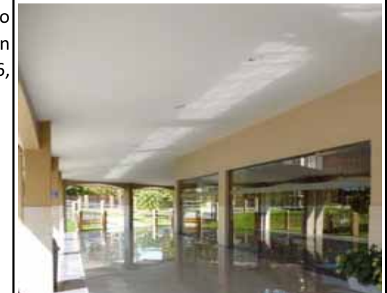
FIG.496 Fotografía del cielo falso que cubre el vestíbulo.
