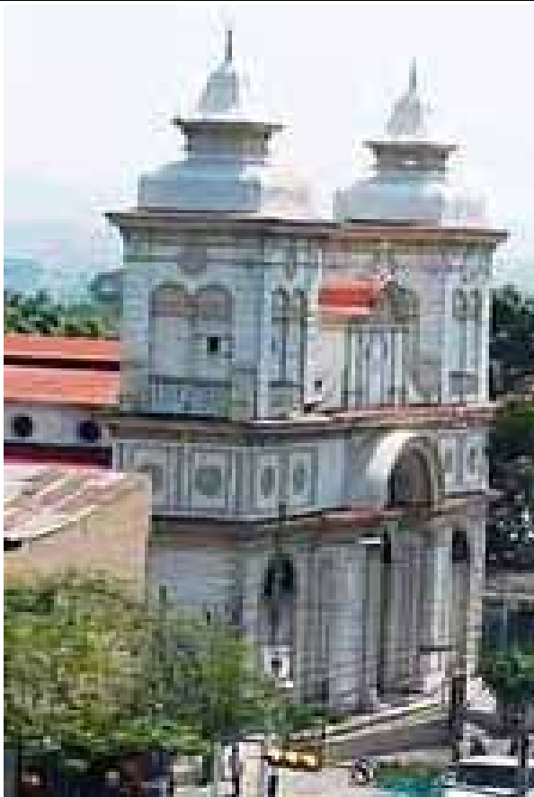
FIG.180 Fotografía de la iglesia parroquial, donde se puede apreciar la cubierta de lámina galvanizada.
