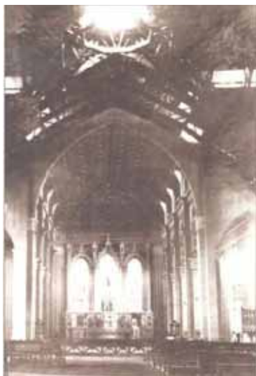
FIG.261 Fotografía interior de la iglesia parroquial, tomada en 1929 durante la primer etapa de construcción.
