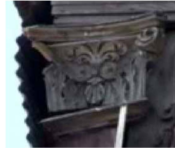
FIG.379 Fotografía del capitel de las columnas de la torre norte
