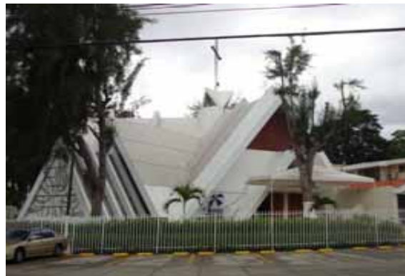
FIG.745 Fotografías exteriores de la iglesia parroquial San Benito, donde se aprecian las losas de concreto del techo.
