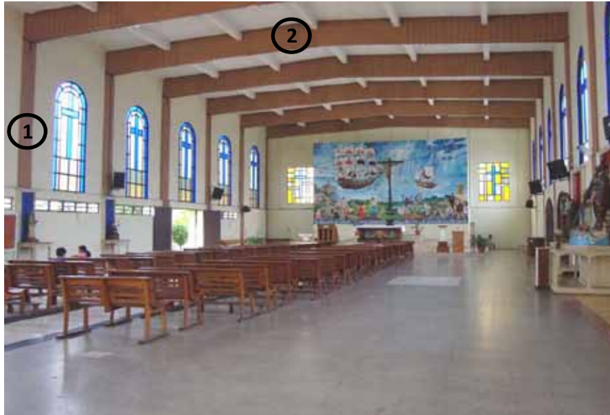
FIG.246 Fotografía del interior de la iglesia parroquial Nuestra Señora de la Merced, tomada en 2012. Nótese la serie de marcos de concreto armado que constituyen el sistema estructural de la misma.
