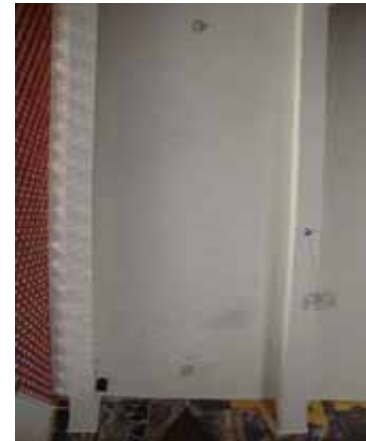
FIG.743 Fotografía de las vigas de concreto armado
