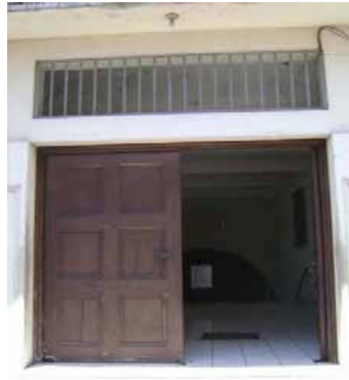
FIG.73 Fotografía del acceso que conduce a la cripta.
