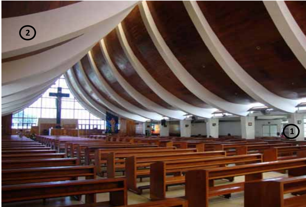
FIG.714 Fotografía interior de la iglesia parroquial Corazón de María, donde se observan los elementos estructurales que la conforman.
