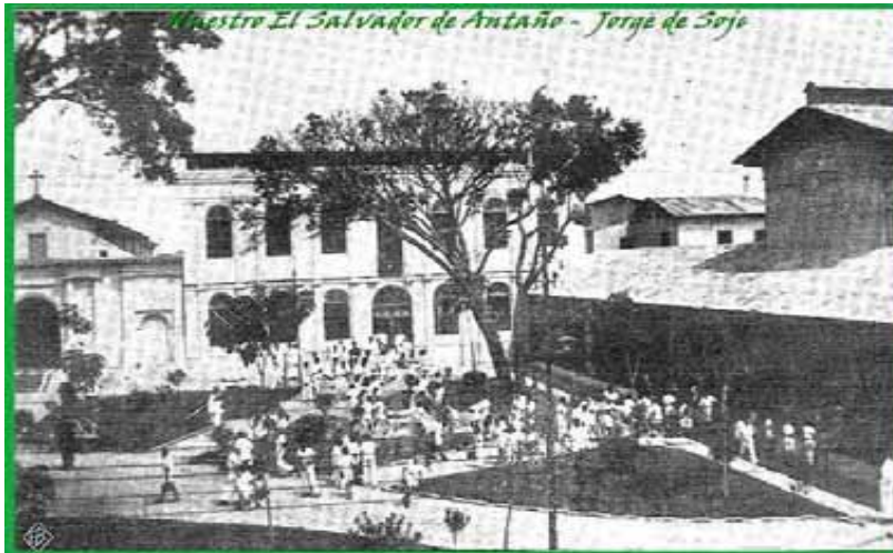
FIG.664 Fotografía de las instalaciones del viejo colegio Externado San José, tomada en 1942. A la izquierda se observa parte de la fachada principal de la Iglesia San José.
