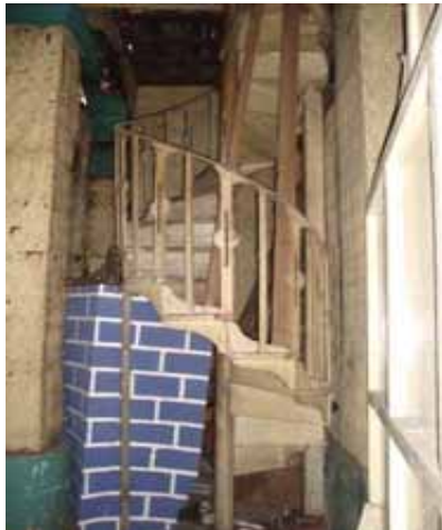
FIG.366 Fotografía de la escalera de caracol que conducía hacia el coro, tomada en 2012.
