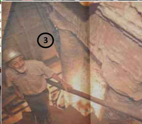
FIG.532 Fotografía interior, donde se observa la fachada original, oculta detrás de la de madera.
