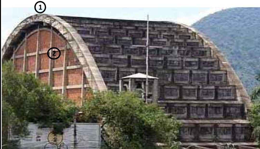
FIG.138 Fotografía exterior de la iglesia parroquial El Rosario, donde se observan los elementos estructurales que la conforman.
