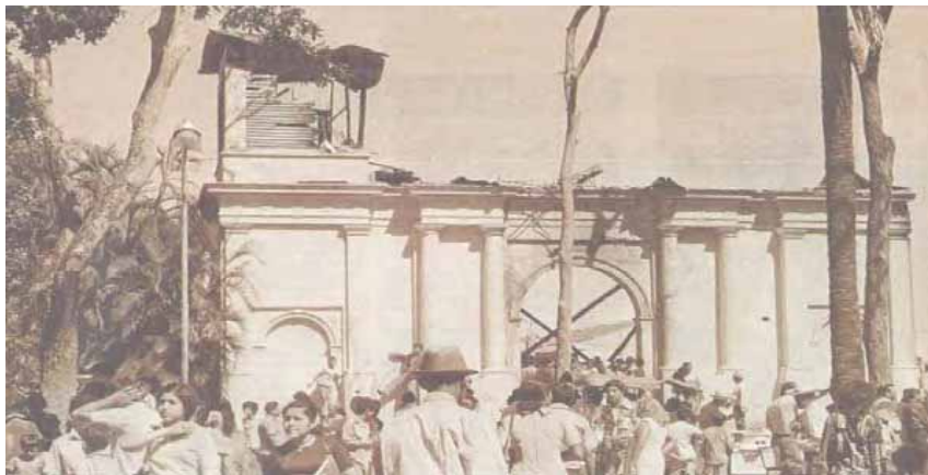
FIG.194 Fotografía del estado en el que quedó la iglesia parroquial San José después del incendio de 1975.
