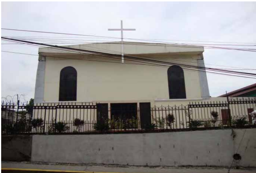
FIG.227 Fotografía de la iglesia parroquial La Merced, tomada en 2012. A diferencia de la FIG.226, el ingreso sobre la 10a. Av. Sur ya no se encuentra.
