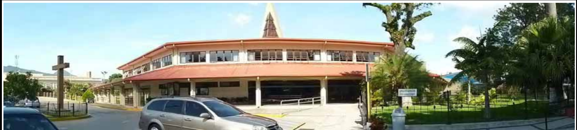
FIG.490 Fotografía de la elevación principal de la iglesia parroquial Inmaculada Concepción de Santa Tecla. Nótese la sobriedad decorativa en la fachada.
