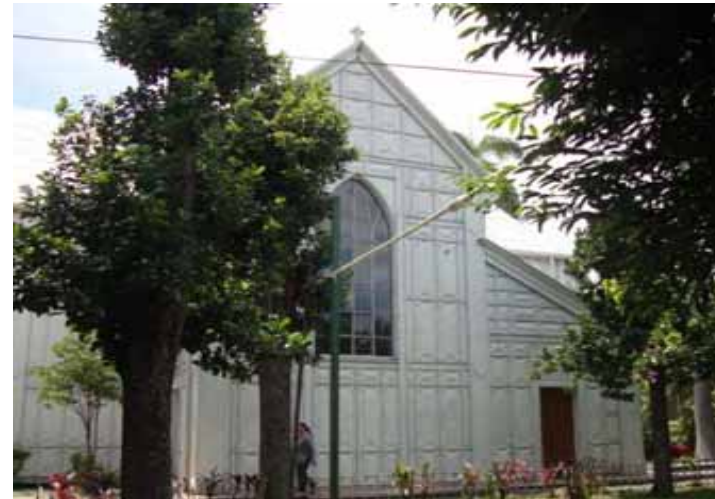
FIG.558 Fotografía del costado norte del transepto.
