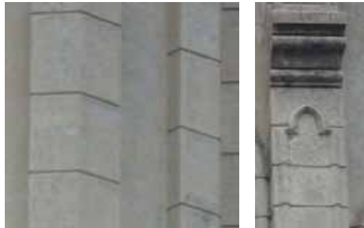
FIG.285 Izquierda: Fotografía del almohadillado en una de las aristas de la torre norte. Derecha: Fotografía del almohadillado de una de las pilastras.
