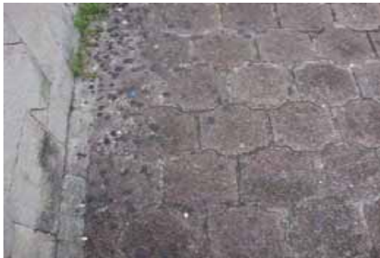
FIG.723 Fotografía del material de piso exterior
