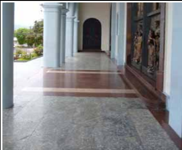
FIG.660 Fotografía del piso del vestíbulo de la iglesia.
