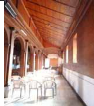
FIG.404 Fotografía de la nave lateral suroeste del templo.
