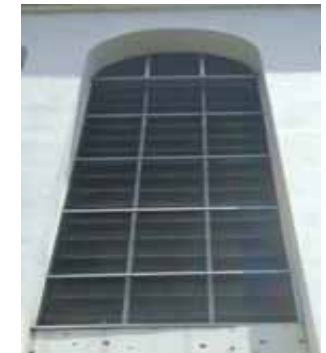
FIG.65 Fotografía del tipo de ventana del transepto.
