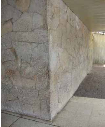
FIG.721 Fotografía del acabado exterior en las paredes de la iglesia parroquial.
