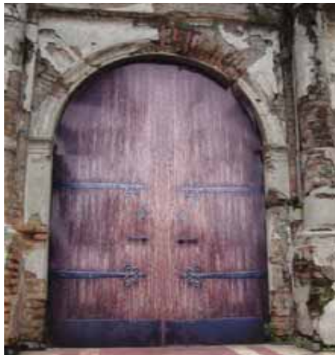
FIG.203 Fotografía del acceso principal, de lo que fue la iglesia parroquial San José, tomada en 2012.
