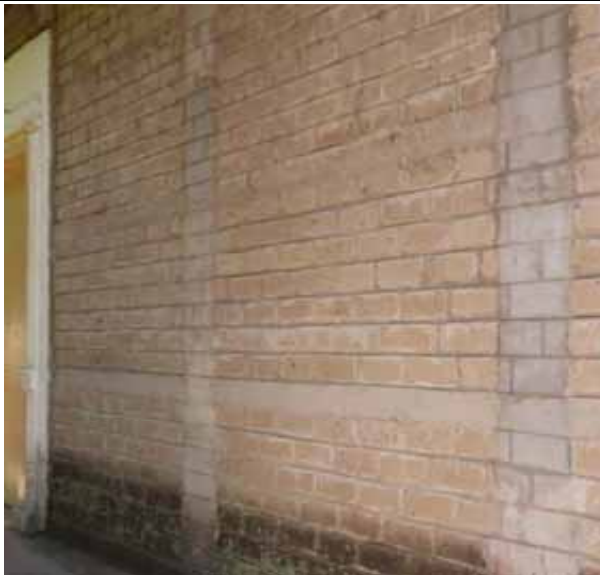
FIG.468 Fotografía de las paredes exteriores de la iglesia.
