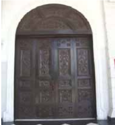
FIG.595 Fotografía de la puerta de los accesos laterales.
