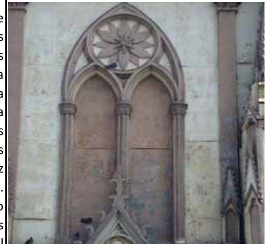
FIG.521 Fotografía del detalle de la tracería tallada en madera de las ventanas falsas.
