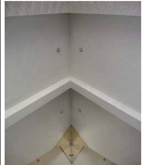
FIG.746 Fotografía interior de las vigas y losa de concreto vista del techo.
