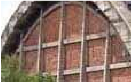
FIG.145 Fotografía exterior de la pared norte.
