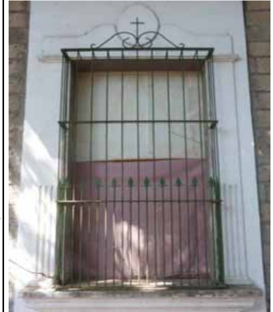
FIG.457 Fotografía exterior de una de las ventanas.
