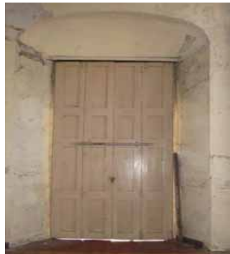
FIG.516 Fotografía interior del vano del acceso principal a la iglesia.
