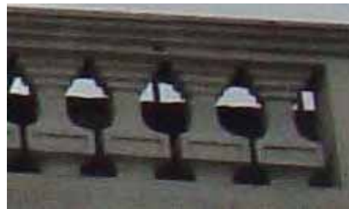
FIG.67 Detalle de balaustrada
