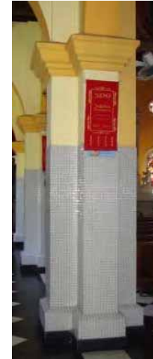
FIG.612 Fotografía de una de las columnas cruciformes.
