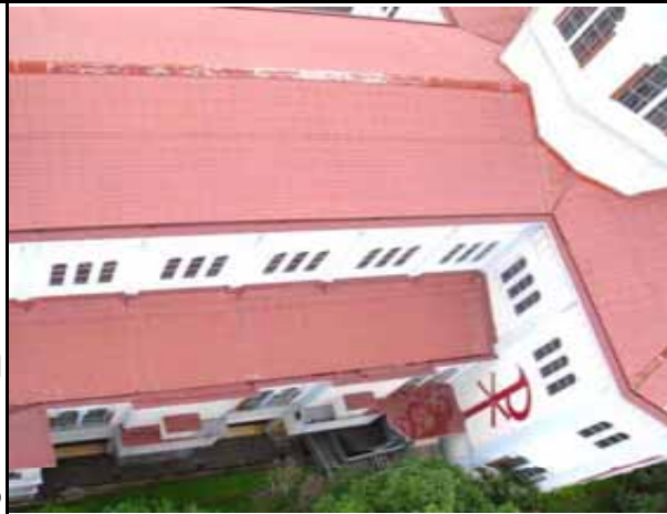
FIG.654 Fotografía de la cubierta de la iglesia.
