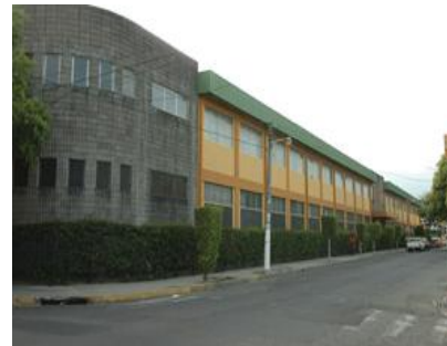
Fotografía N° 10 Colegio Santa Inés
