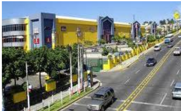
Fotografía N° 39 Centro Comercial Plaza Merliot sobre calle Chiltiupan
