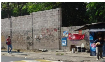
Fotografía N° 58 Muro del Instituto ITCA sobre la 2ª calle oriente poniente
