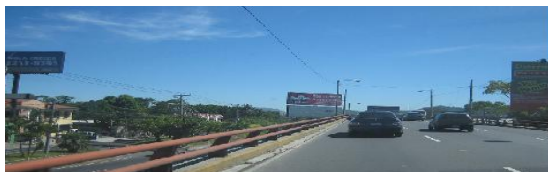
Paso Desnivel Carretera Panamericana Fotografía N° 92
