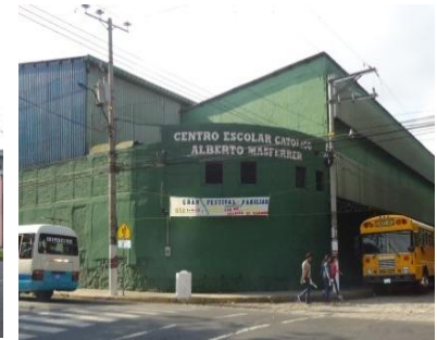
Fotografía N° 7 Centro Escolar Católico Alberto Masferrer
