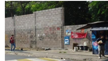
Fotografía N° 59 Muro del Instituto ITCA sobre la 2ª calle Oriente - Poniente
