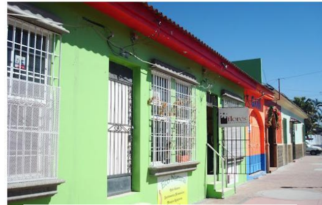
Fotografía N° 52 Paseo El Carmen 1°Calle Oriente
