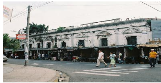
Fotografía N° 46 Acera ubicada sobre la casa Guirola
