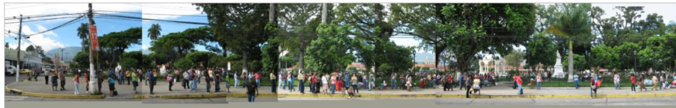
Fisuras, grietas, y desprendimiento de material en el cordón cuneta del perfil Suciedad en bordes de jardineras
