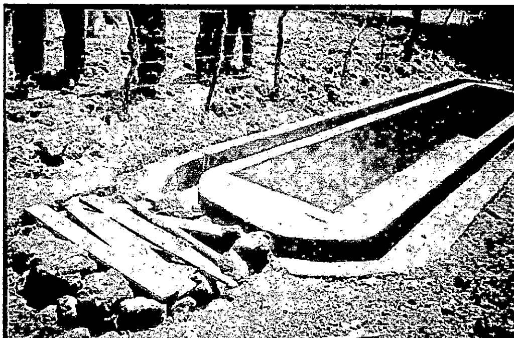
Anexo A.4 Biodigester domestico rural de media bolsa en etapa final de construcción
