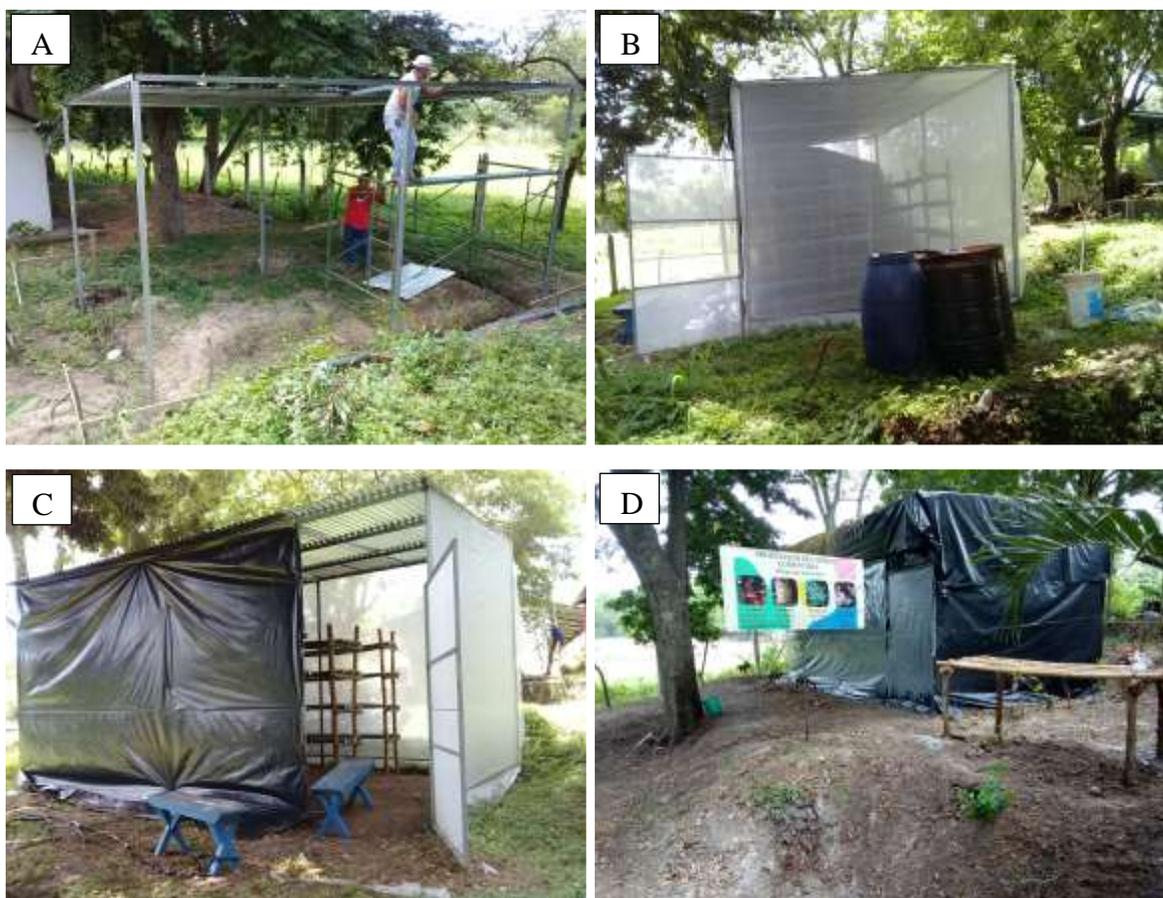
Figura 11. Construcción del módulo para producción del hongo ostra. A: colocación de estructura metálica; B: instalación de tela antiviral; C: colocación de nylon negro; D: módulo terminado.
