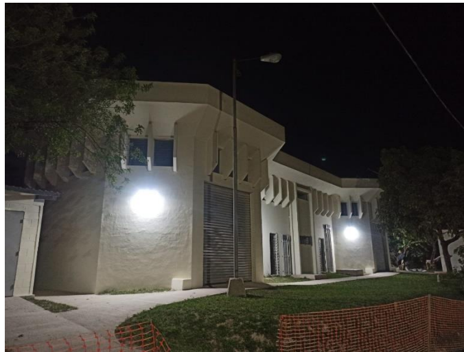
Figura 5.10: Edificio de potencia de la Escuela de Ingeniería Eléctrica de la Universidad de El Salvador.
