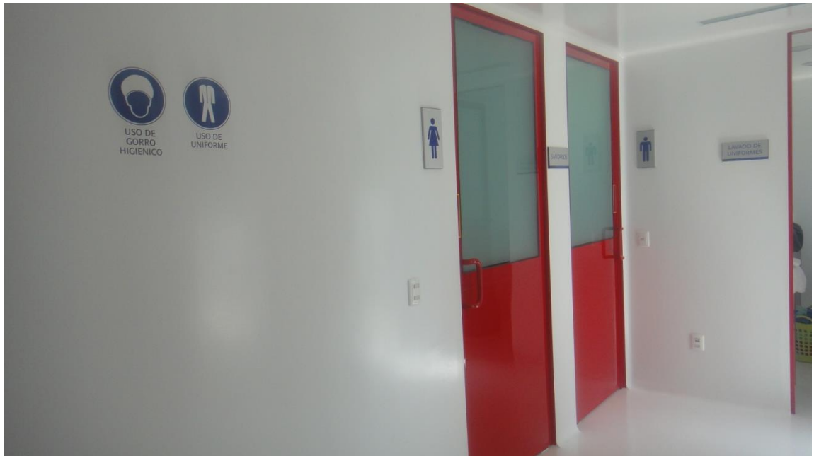
Figura N° 9 puertas de acceso de vestidores y lavandería a esclusa del área de producción
