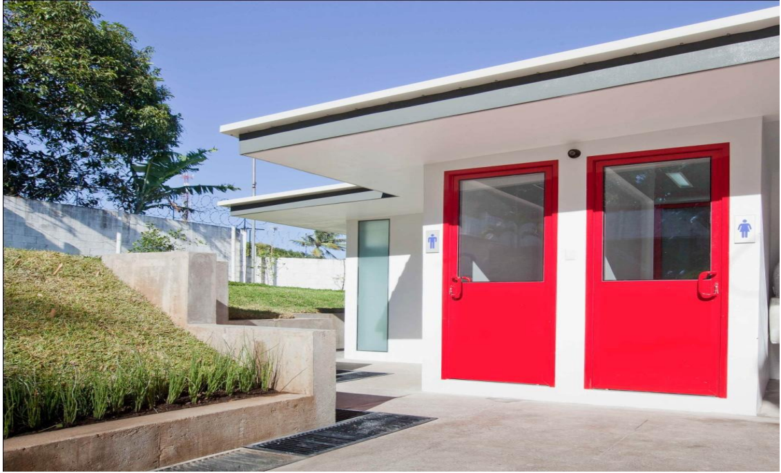
Figura N° 5 Puertas de acceso a baños, duchas y vestidores.
