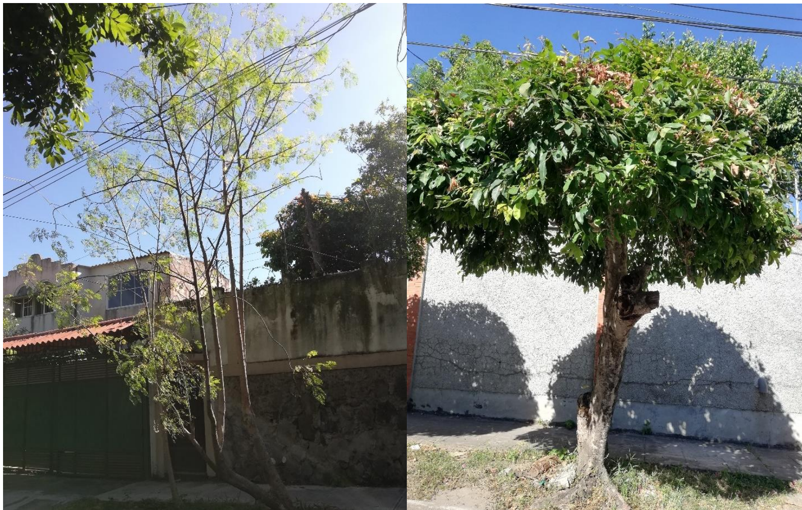
Figura A-12. Árboles en Avenida Bolívar que presentan conflicto con el tendido eléctrico.
