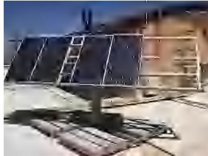
Imagen N°63: Panel fotovoltaico y banco de baterías bajo él.
