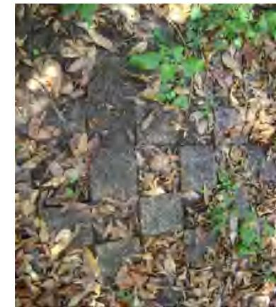
Imagen N° 23: Adoquinado a un costado de la calle para la permeabilidad del terreno.
