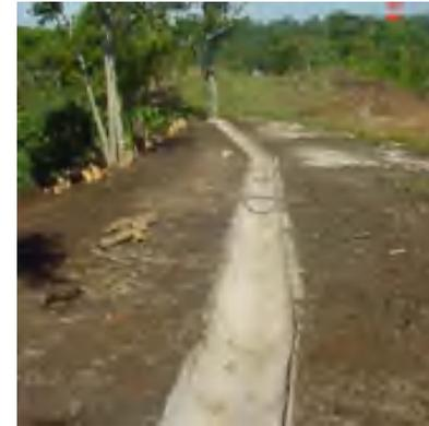
Imagen 56: Cuneta en la corona del talud.
