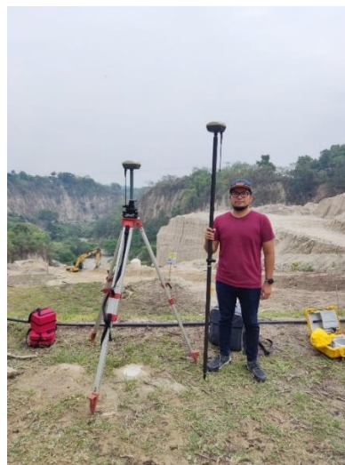
Figura 139 - Colocación de bastón al Rover
