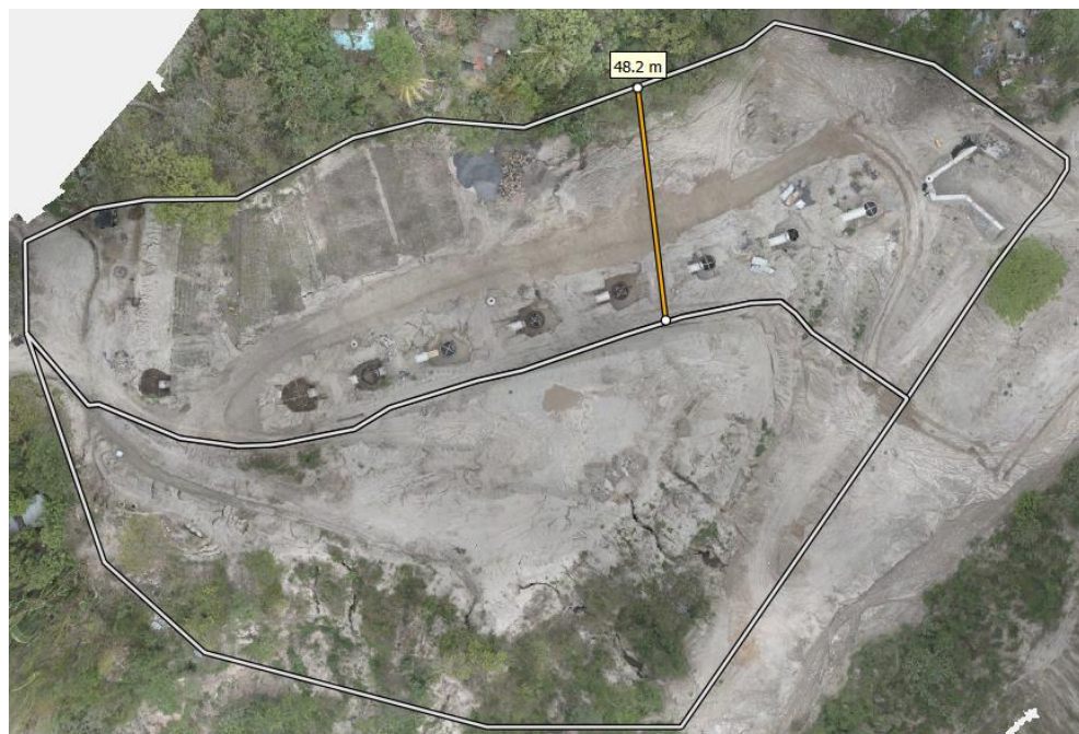
Figura 252 - Longitud de la cárcava intervenida
