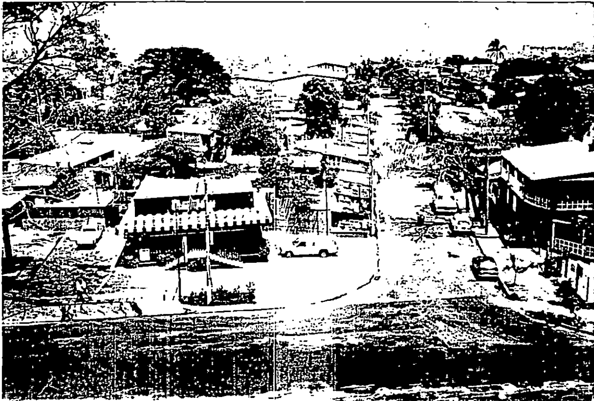
FOTO #3: Se muestra el hacinamiento del conjunto habitacional sin muestras de ordenamiento de ningún tipo.
