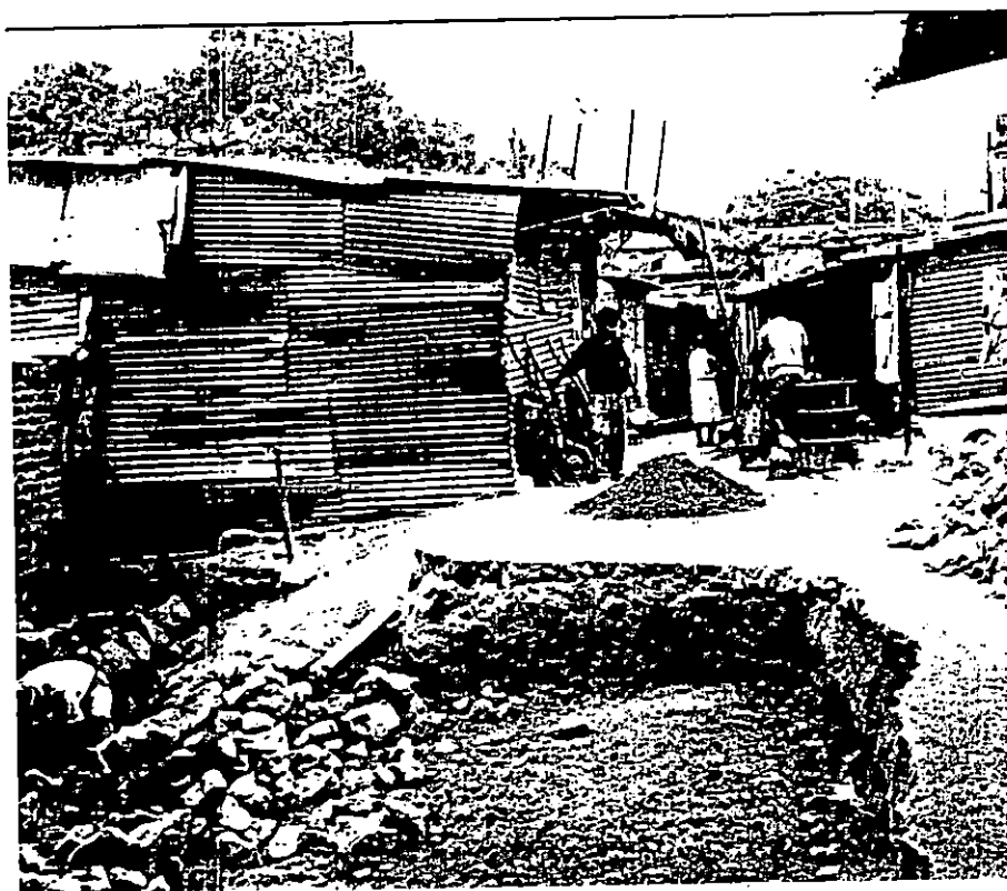
FOTO #5: SE MUESTRA LA UTILIZACION PREDOMINANTE DE LA LAMINA EN LAS PAREDES, COMBINADO CON ESTRUCTURA DE MADERA.
