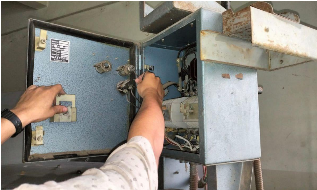
Fig. 3.1. Inspección del panel de control de temperatura existente en el horno.
