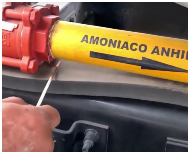
Fig. 4.1. Prueba de fuga de amoníaco con una mecha de azufre.
