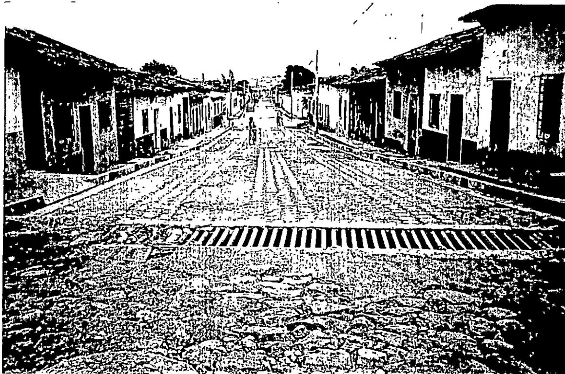
Caja tragante ubicada al final de la Avenida 2 de abril sur, la cual se conecta al ramal ubicado sobre la misma avenida, por medio de tubería de diámetro de treinta pulgadas.
