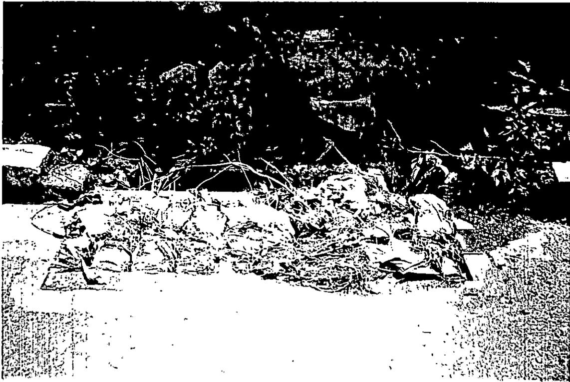
Caja tragante tragante con parrilla de hierro fundido, de construcción reciente, ubicada en la intersección de la 1a. Av. Sur y 5a. Calle Oriente. Se muestra la saturación debida a los sólidos flotantes arrastrados por la fuerte escorrentía proveniente del sur de la ciudad. Además puede observarse el deterioro de la infraestructura.
