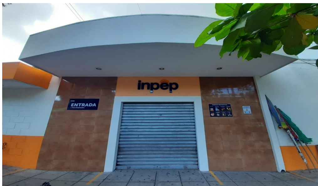
Figura 4. Acceso principal del Instituto Nacional de Pensiones de los Empleados Públicos.
