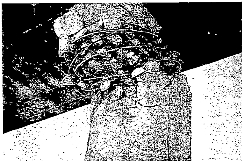
FIGURA 2.2.17 FALLA POR CORTANTE DENTRO DE LA JUNTA PLÁSTICA. TERREMOTO DE SAN FERNANDO, 1971.
