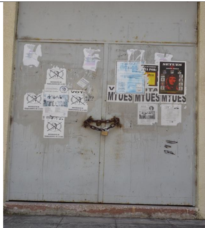
Figura 7 Antiguo local de administración académica, ahora bodega de documentación y materiales.
