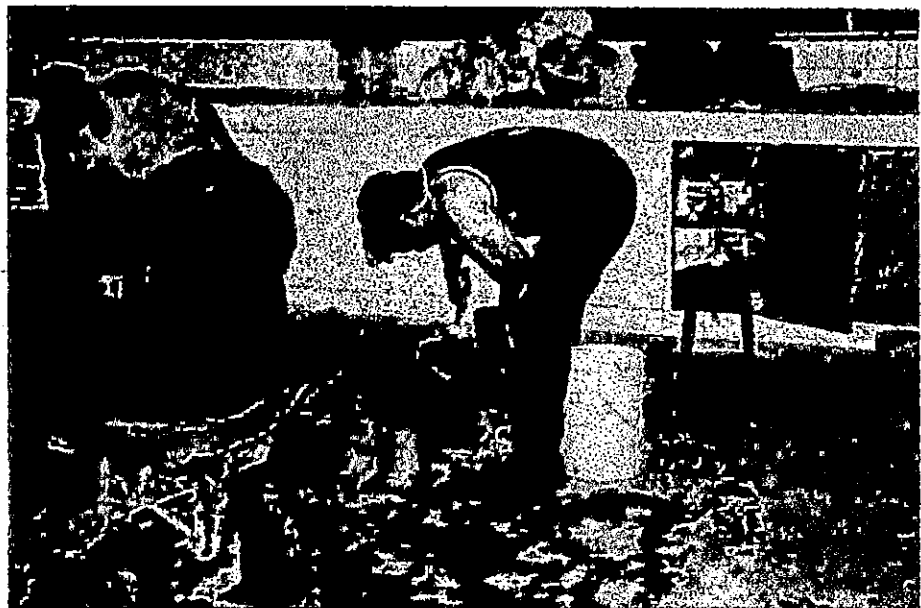
FIGURA 25. GOLPEADO DE MOLDE PARA EXTRAER EL AIRE ATRAPADO.
