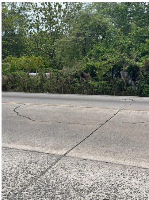
Figura 2.12 Agrietamiento esquinado
