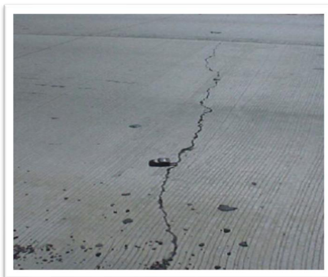
Figura 2.8 Agrietamiento transversal
