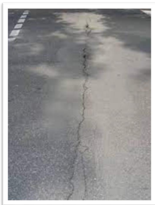
Figura 2.11 Agrietamiento longitudinal
