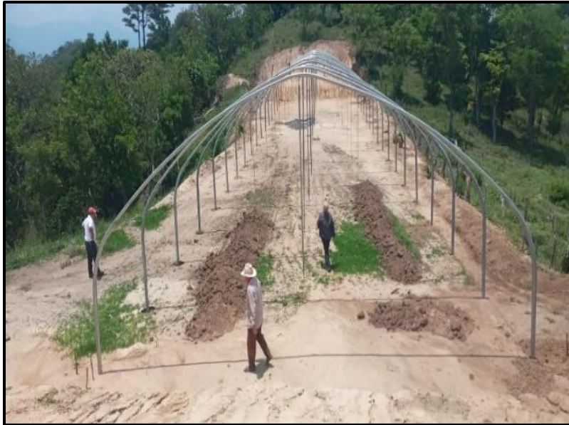
Anexo 13. Instalación de invernadero, proyecto RECETO – Adenda II.
