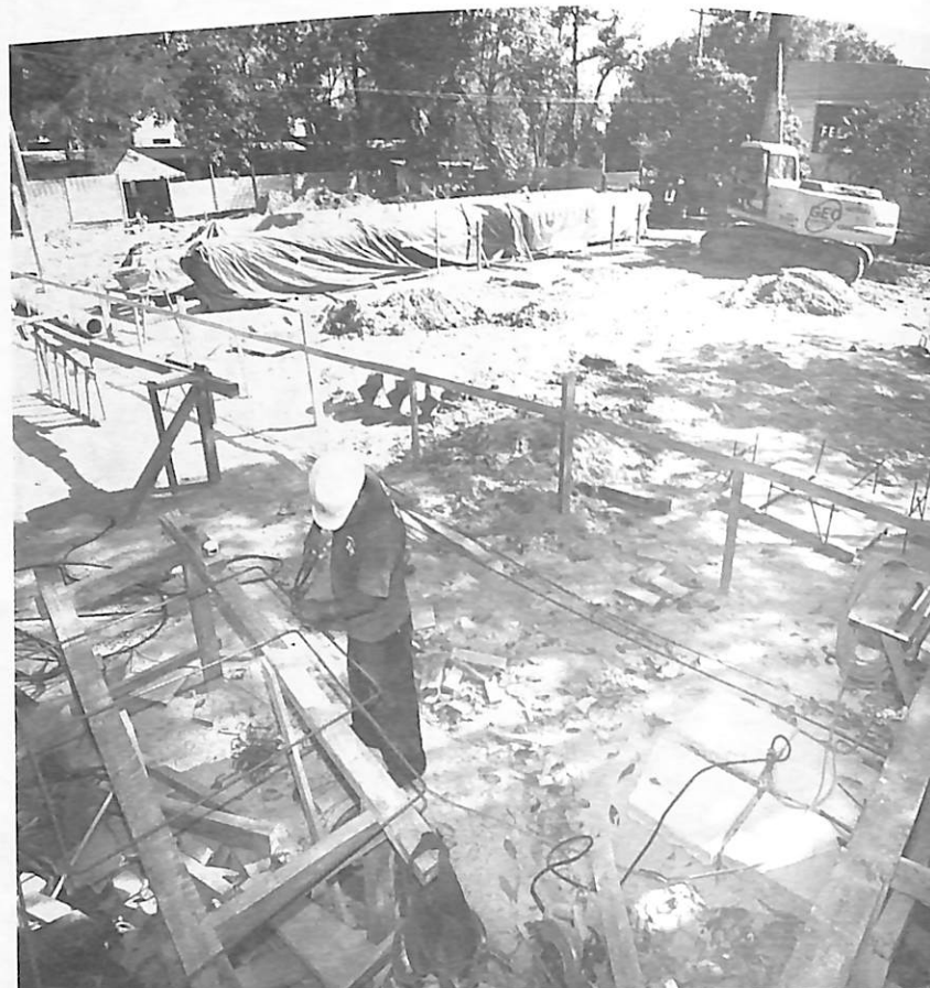
Construcción del Edificio de Aulas en la Facultad de Ciencias Económicas.
