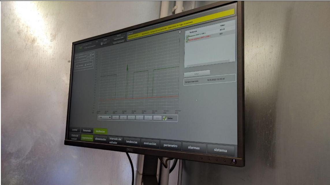
En la **Fotografía 3** se observa un informe del equipo de lo que se bombea, durante la visita comentaban que deben tener un control de eso, porque al final que alimentan el digestor se tiene que esperar un lapso de 15 o 20 días para obtener el resultado de esa alimentación, si se tiene alguna baja en la generación pueden verificar en el control del bombeo que fue lo que lo ocasionó.
