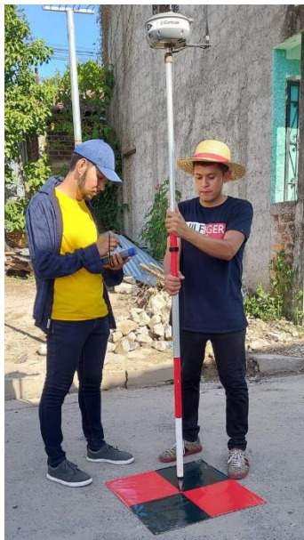
Imagen 3 - 32 Colocación de receptor móvil en el PCF2.
