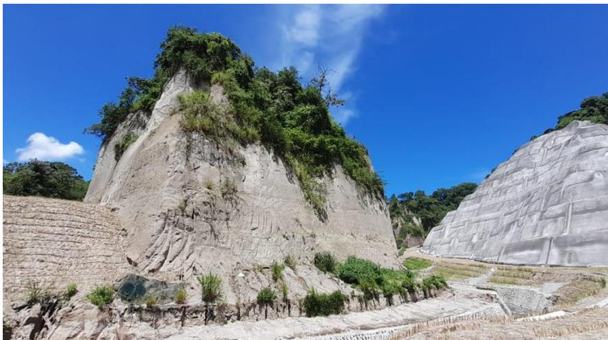
*Imagen No 9-2. Quebrada El Chagüite, al frente el cerro de interés con vegetación en la parte superior, forma un talud debido a la erosión del costado de la quebrada*
