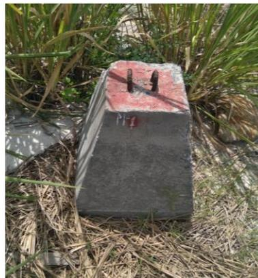
*Imagen No 9-5. Mojón usado para el vértice geodésico.
