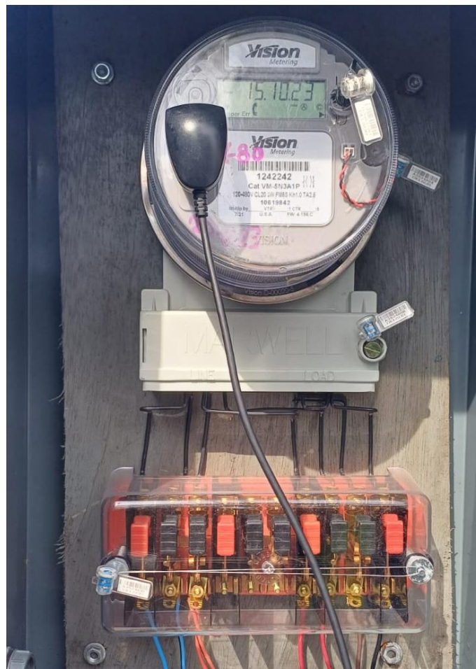
Imagen C.3 Cable óptico USB conectado a medidor
