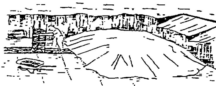
Figura 9 Construcción del drenaje de gases
