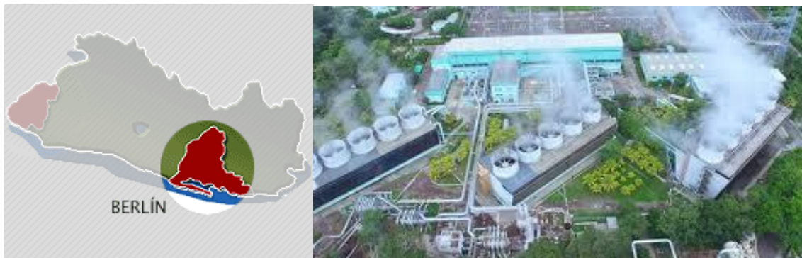
Figura 3: Central Geotérmica de Berlín. Fuente: LaGeo, 2023d
