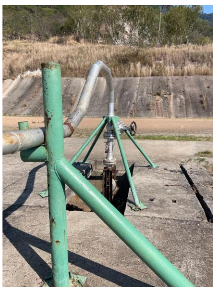
Figura 116: Pozo geotérmico instalado por la GEO. Fuente: Fotografía propia
