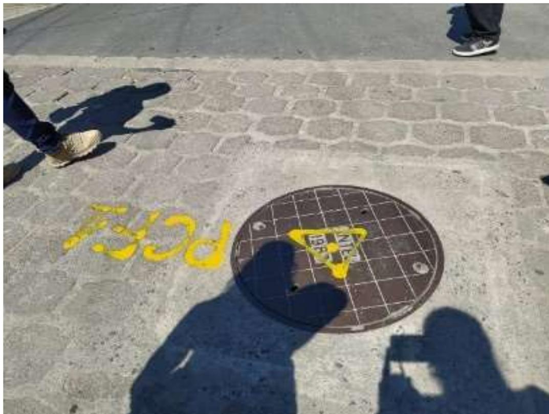
*Imagen 3.2.1.2: Tapadera de pozo marcado con pintura para ser utilizado como punto de control.*
