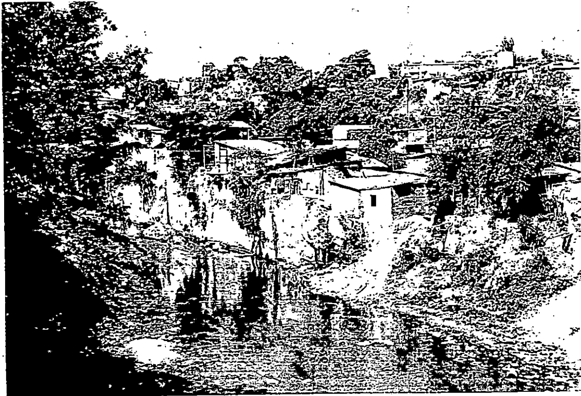
Foto 7.5 Ubicación de viviendas en la corona del talud, al borde del mismo. com. San Luis Portales
