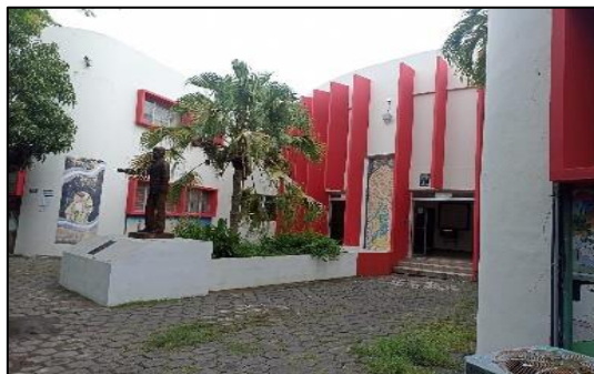
Figura 3.3 Edificio Ex Administrativo o Riñón
