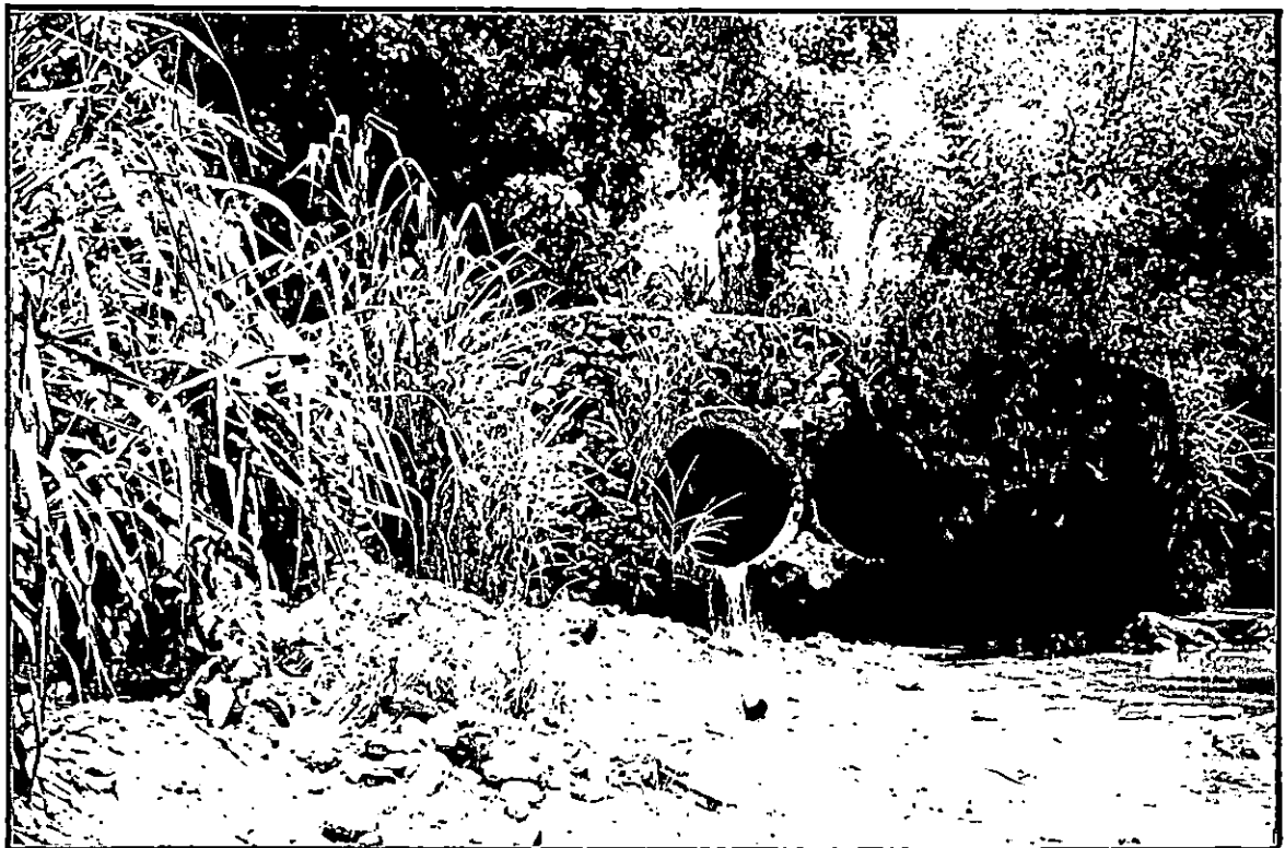
l) Descarga de las aguas residuales del rastro a la quebrada Agua Fría.
