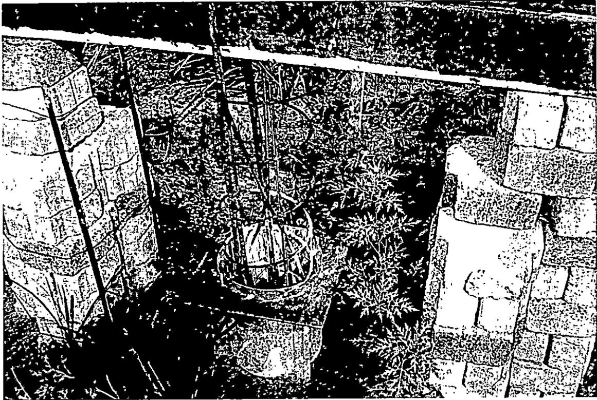
Fot. C.5. Esquema utilizado para detener armadura del pilote de prueba.
