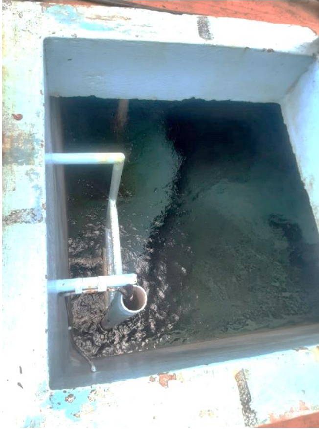
Ilustración 3-7 Interior de cisterna
