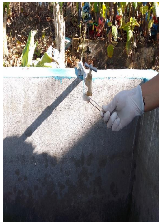
Ilustración B-II Desinfección por flameo de grifo en punto 2
