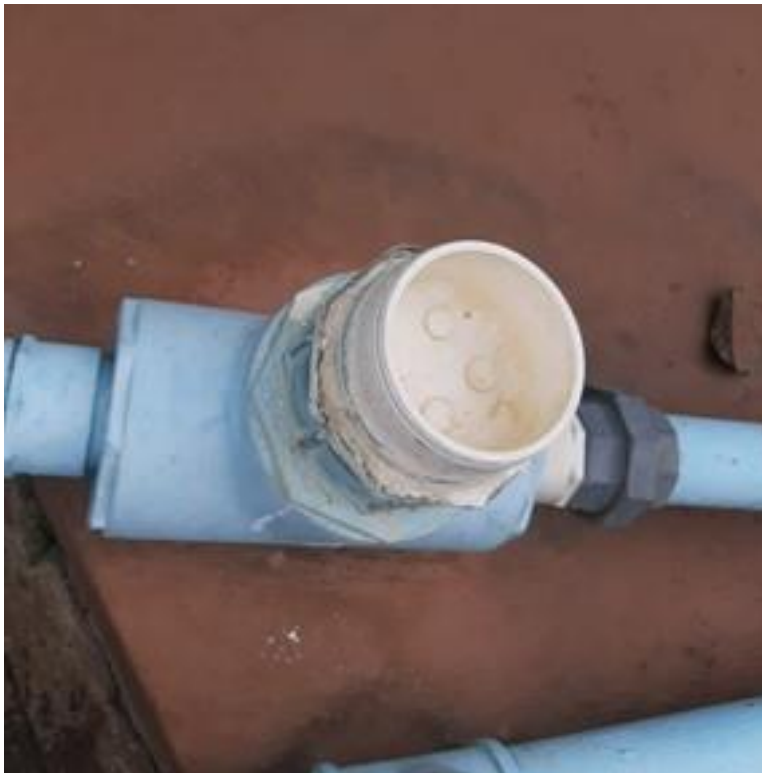
Ilustración 3-5 Dosificador de pastilla de \text{Ca}(\text{ClO}_4)_2
