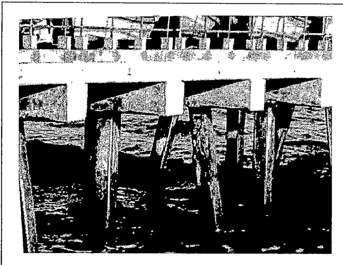
**Fotografía No. 1** Corrosión en una Columna del Puerto de la Libertad, se aprecia un color rojizo y la presencia de grietas causadas por la exposición severa de la estructura.
