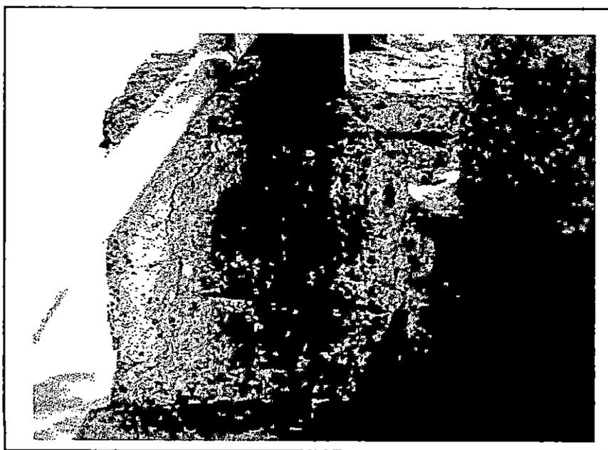
**Fotografía No. 2** Corrosión acentuada en una sección del Puerto de la Libertad, puede verse como el recubrimiento ha dejado desprotegido el acero de refuerzo y este es atacado por sustancias salinas agresivas.
