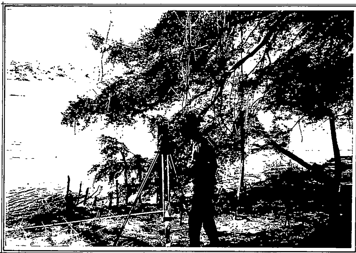
LEVANTAMIENTO DE SECCION TRANVERSAL, INICIANDO EN UNA DE LAS MARGENES (ZONA DEL BAJO LEMPA)
