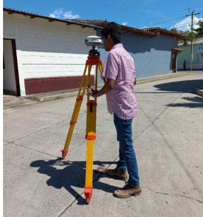
Imagen No. 3.2.2.3. – Centrado y nivelado del receptor base Fuente: Elaboración propia
