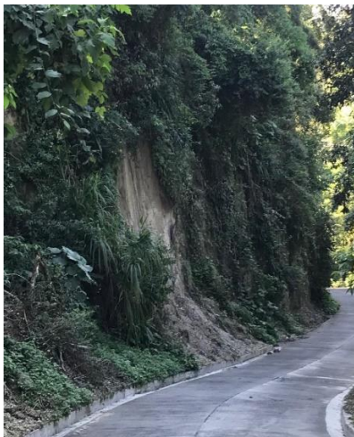
Figura 21. Zona de deslizamientos de tierra en Monte San Juan.
