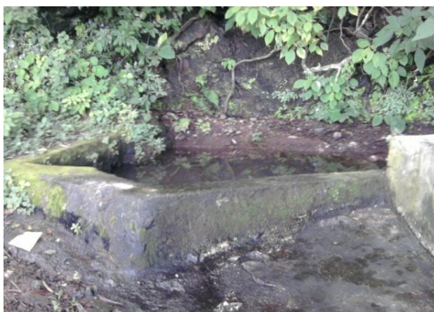
Figura 3.21. Fotografía de obra de captación de manantial el Ojushte, Municipio de San Miguel de Mercedes, Departamento de Chalatenango.
