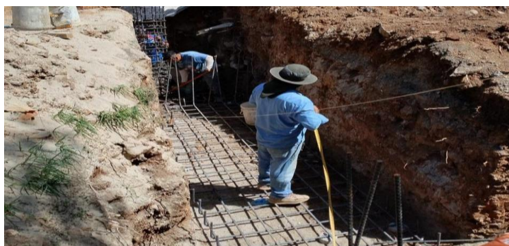
“Armado y colocación de acero para zapata y tensor”.
