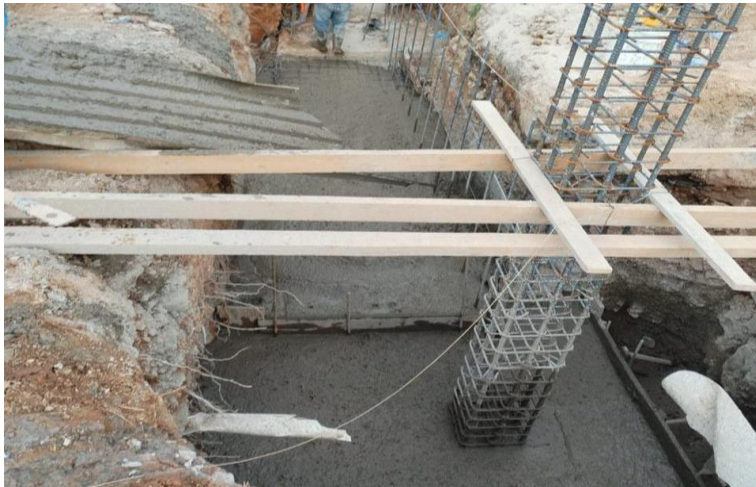
“Colado de zapata y tensor”
