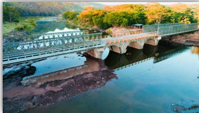
Figura 1.6 Puente provisional sobre el río Titihuapa, Municipio de San Idelfonso, San Vicente y Ciudad Dolores, Cabañas, El Salvador. Fuente: MOP
