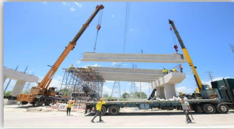
Fig. 4.9: Estructuras izadas, Fuente: MOP
