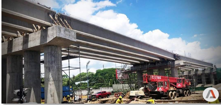
Fig. 4.6 Paso desnivel UNICAES, Santa Ana, El Salvador. Fuente: CIVING S.A de C.V
