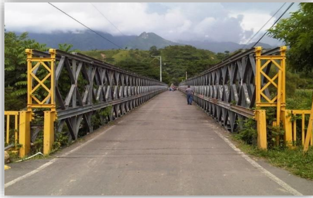
Fig. 4.7 Puente sobre el Río Lempa, Municipio de Citalá, El Salvador
