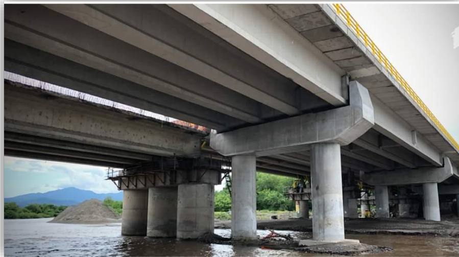
Fig. 1 Puente salvando un obstáculo natural. Fuente: Civing S.A de C.V.
