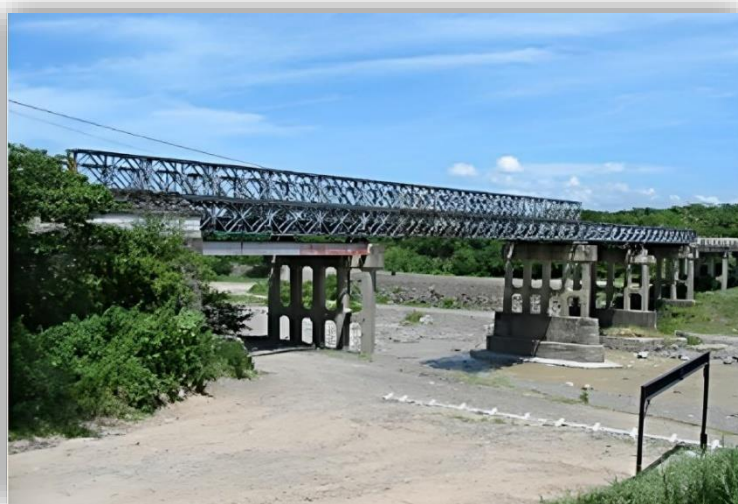
Figura 1.7 Puente provisional Bailey sobre el río Jiboa, La Paz, El Salvador
