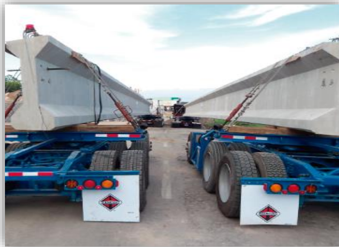
Fig. 4.2 Traslado de vigas presforzadas Fuente: Civing S.A de C.V
