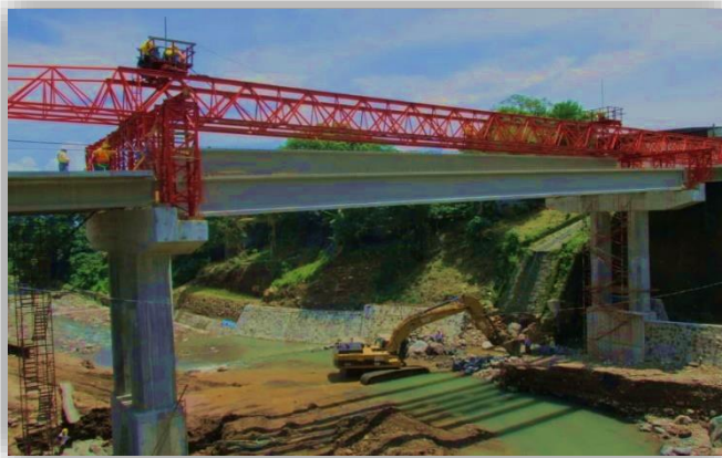
Fig. 4.8 Puente de Gran altura, San Vicente, El Salvador. Fuente:
