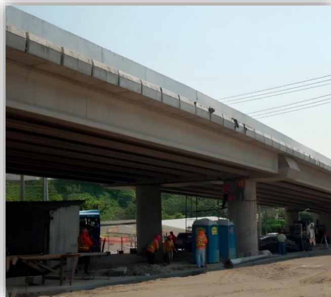
Fig. 1.2 Puente Soyapango. Fuente: Civing S.A de C.V.
