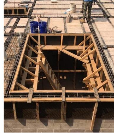
*Ilustración 2: Encofrado de viga perimetral, losa jardín interior*
