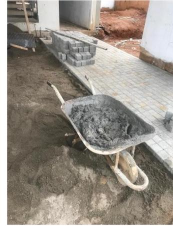
*Ilustración 3: Instalación de Adoquín 10x10 en cochera*
