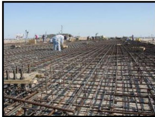
Figura 10: Parrilla de acero de refuerzo
