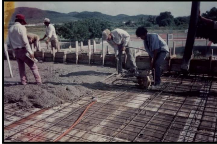
Figura 12: Colado de losa de concreto
