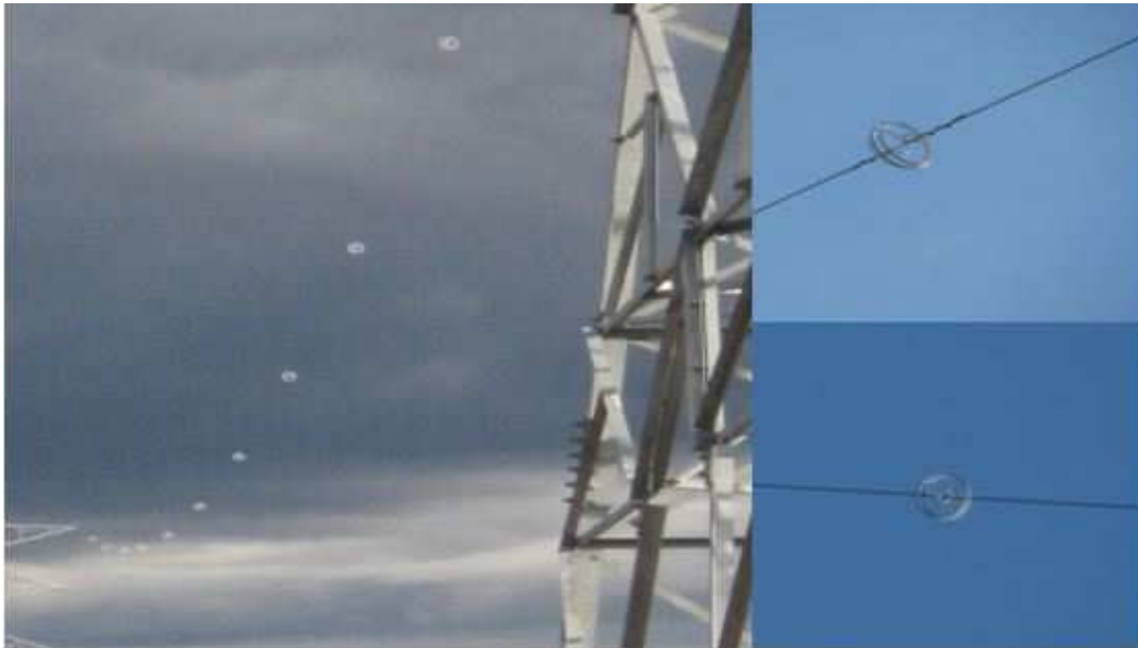
Figura 4. Dispositivo salvapajaros, instalados en los cables de guarda en el área de estudio, nótese la gran visibilidad. (EPR, 2010).
