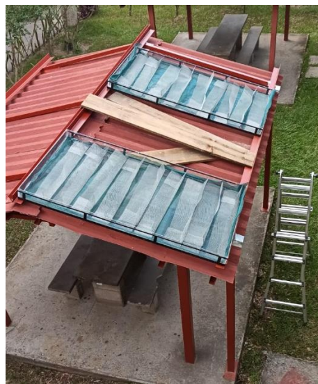
Anexo 39. Paneles ya instalados.
