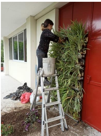
Anexo 34. Implementación del módulo verde vertical en instalaciones de la UDB.
