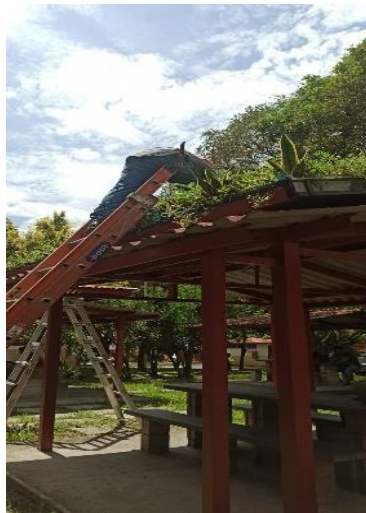
Anexo 50. Poda de paneles verdes instalados en techo.
