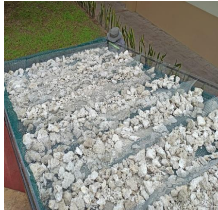
Anexo 40. Módulo ya instalado con piedra pómez.
