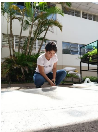
Anexo 36. Construcción de módulos.
