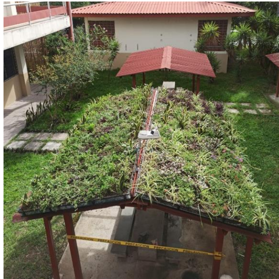
Anexo 47. Instalación del techo verde finalizada al 100%.
