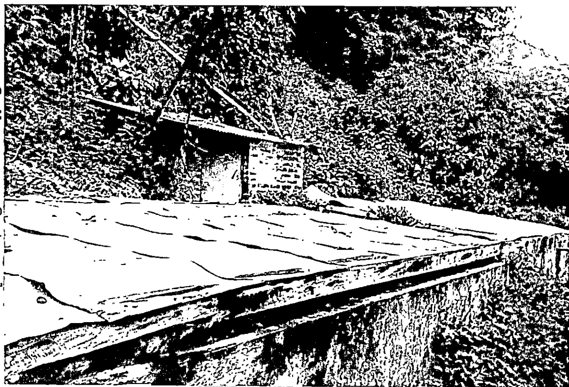
FIGURA 3.13. TANQUES DE REBOMBEO CONECTADOS EN SERIE CAPACIDADES 27 Y 9 \text{ M}^3 . SE MUESTRA ADEMAS LA CASETA DE BOMBEO SISTEMA DE ACUEDUC- TO. LOTIFICACION EL SAUCE. CANTON EL MORRO.
