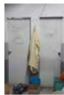
Las puertas de MDF (tablero de fibra de densidad media) abatibles son puertas interiores que están hechas de un material compuesto de fibras de madera y resina prensadas a alta presión. Estas puertas suelen tener un núcleo sólido y uniforme que las hace resistentes y estables.
