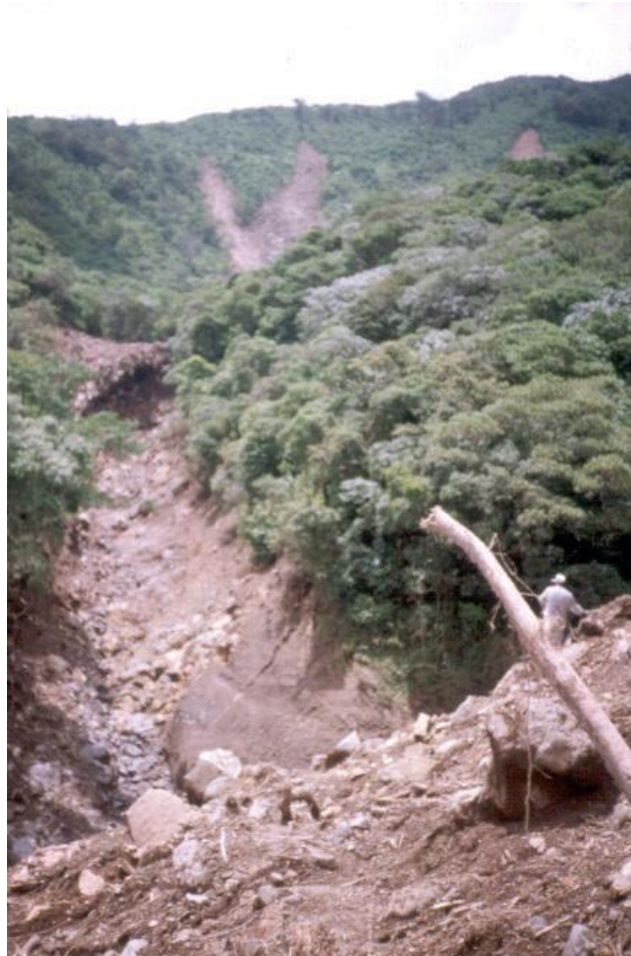
Figura N° 12: Fotografía de inspección de campo del deslizamiento de 1995 sobre el flanco sur del volcán de San Vicente. Tomado de SNET (2004).
