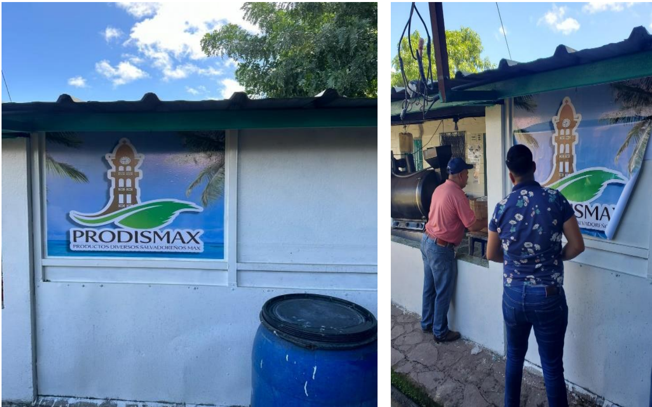
Figura 5. Colocación de vinil con nombre de la marca en las instalaciones de la planta.
